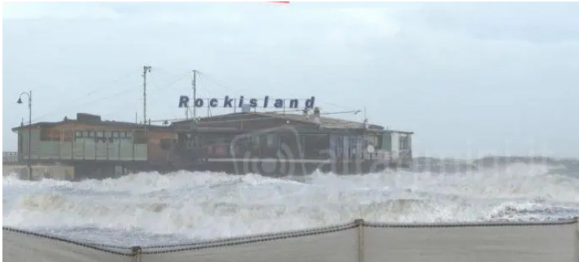
Figura 3-5: L'intensa mareggiata del 23/01/2023 ha portato allo spostamento di alcune barche ormeggiate, con danni alla banchina (fonte: https://altarimini.it/news171051-rimini-la-mareggiata-sposta-le-barche-ingenti-danni-nel-porto.php ).
