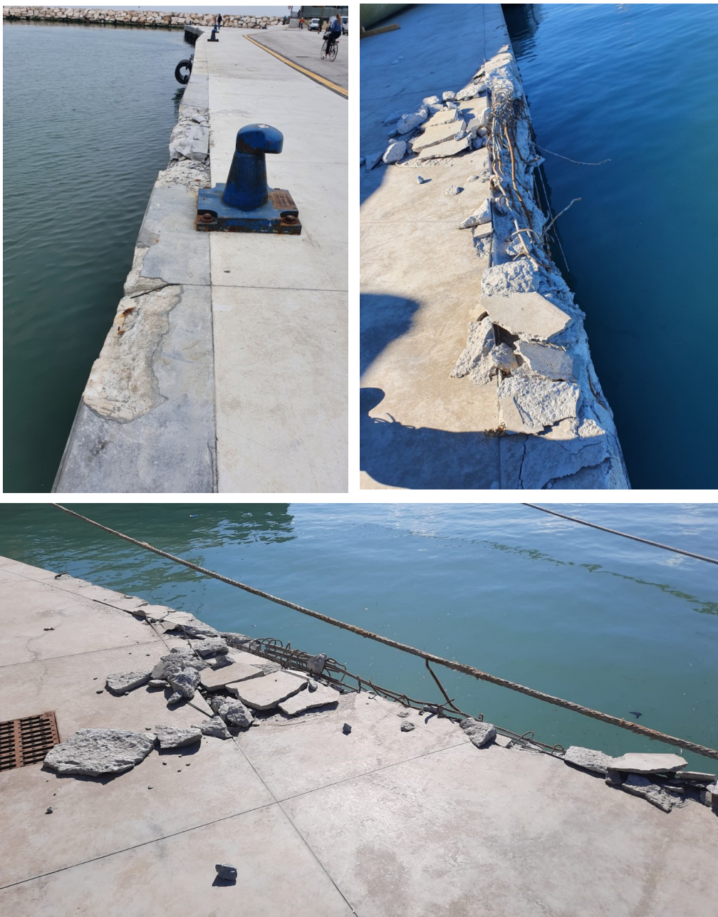
Figura 3-3: Danni alla banchina causati dall’intensa mareggiata dell’11/04/2022 (fonte: https://www.ilrestodelcarlino.it/rimini/cronaca/notte-in-bianco-per-salvare-le-barche-la-regione-acceleri-i-lavori-al-porto-1.7557225 ).
