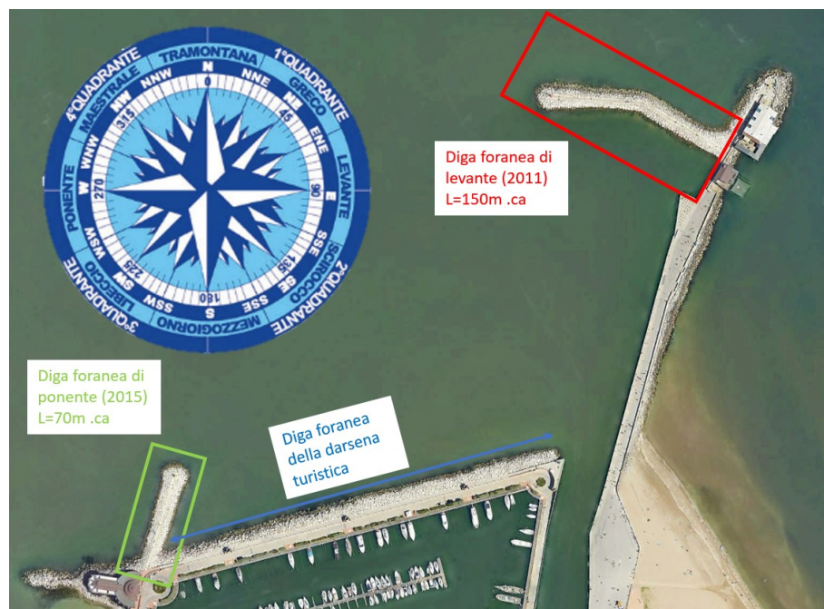
Figura 2-1: Configurazione attuale dell'imbocco del porto canale.
