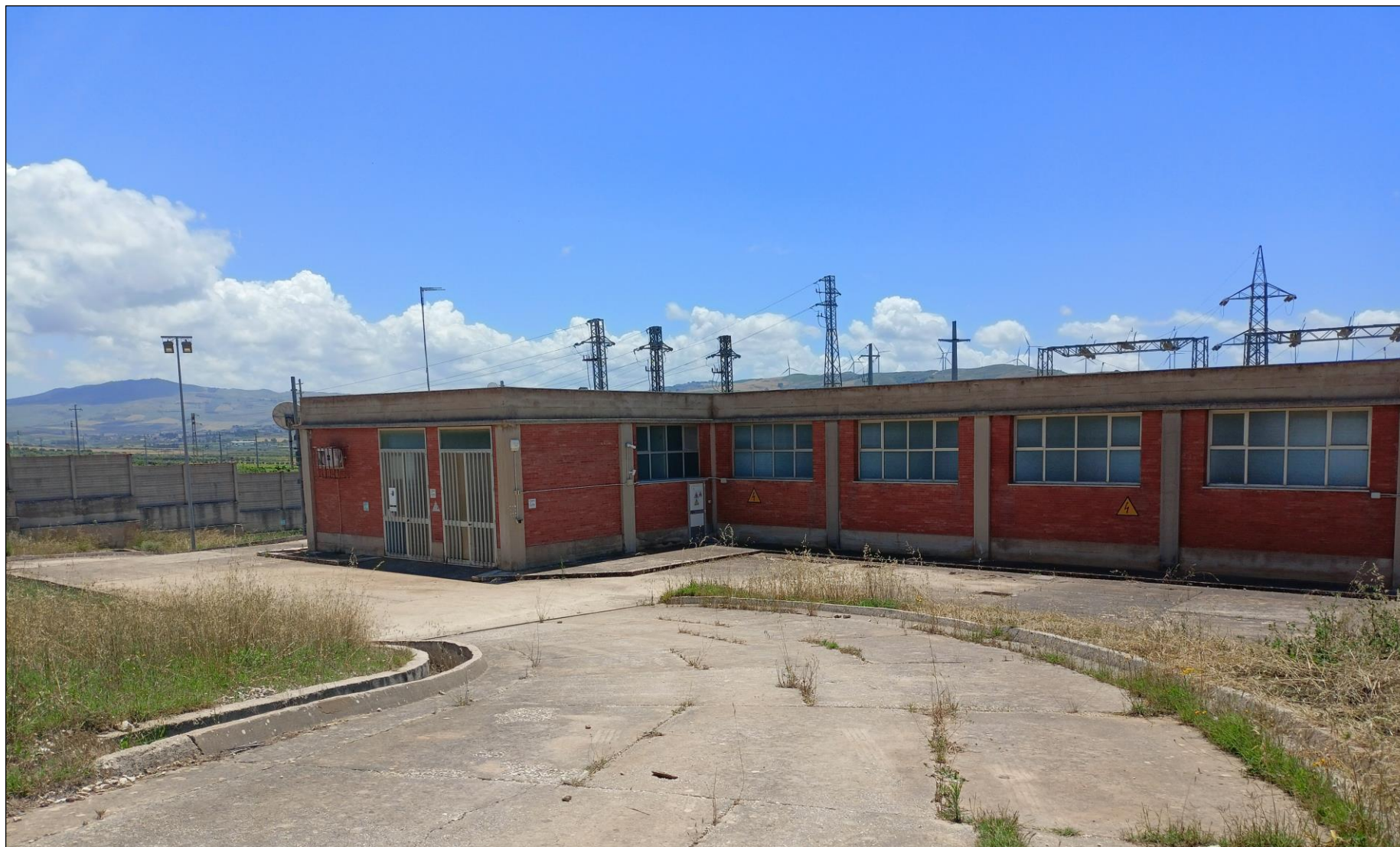
Figura 9. Stato dei luoghi ante operam della CP Custonaci di e-distribuzione S.p.A (POV:8)
