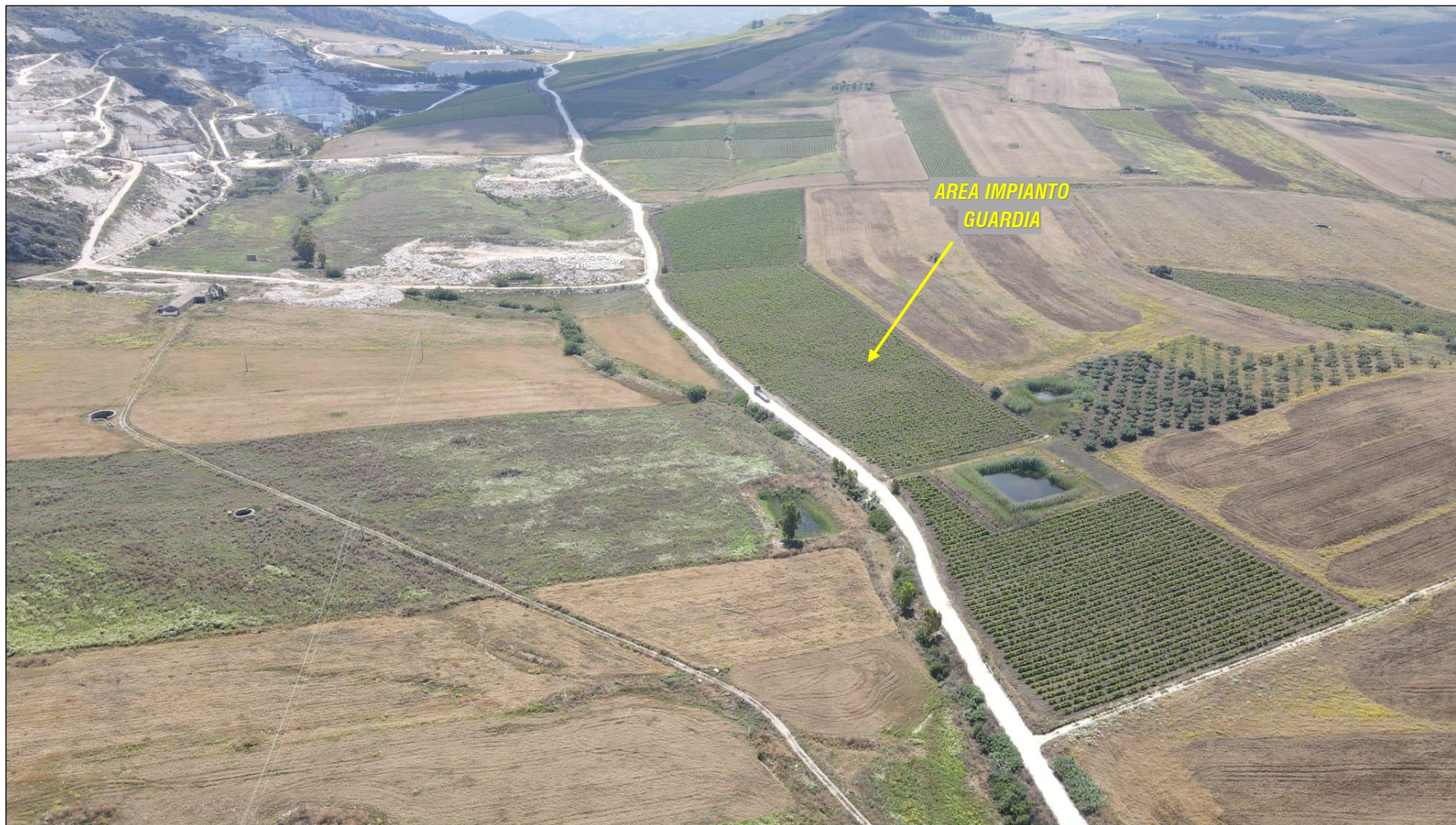
Figura 4. Stato dei luoghi ante operam Impianto Guardia (POV 3: Foto aerea)
