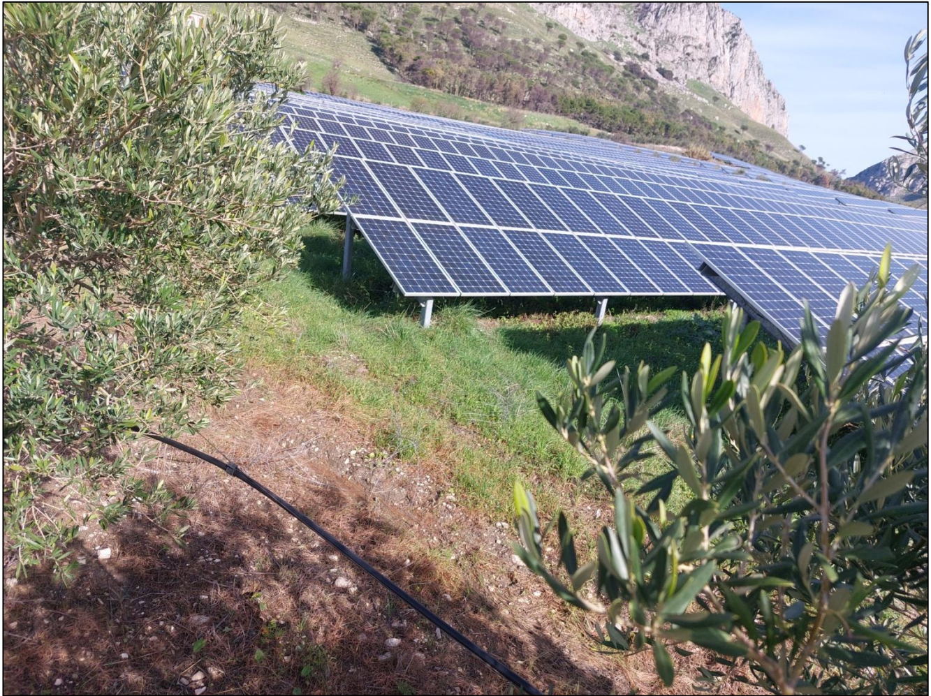
Foto n.2 – Esempio reale di impianto fotovoltaico realizzato a 1,5 Km dalla diga di Piana degli Albanesi con crescita di vegetazione sotto il pannello
