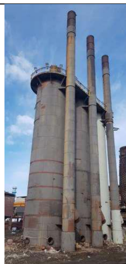
Figura 11. Cowper AFO3; i due più scuri in primo piano risalenti agli anni '20 del secolo scorso verranno conservati e destinati a memoria dell'archeologia industriale.
