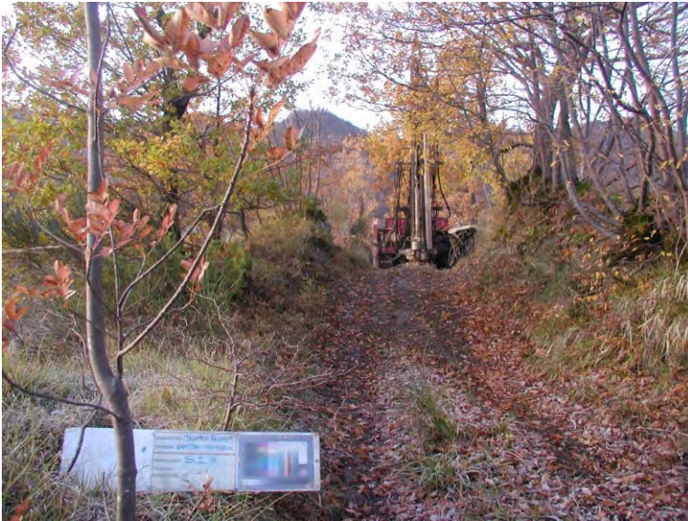
Postazione sondaggio S17
