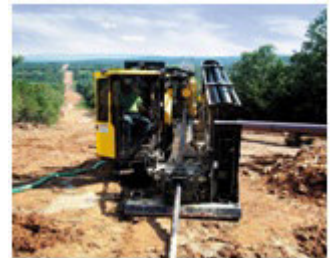
PERFORAZIONI MEDIANTE LA NO-DIG
