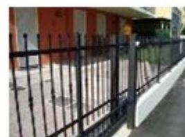
RECINZIONE E OPERE IN FERRO
