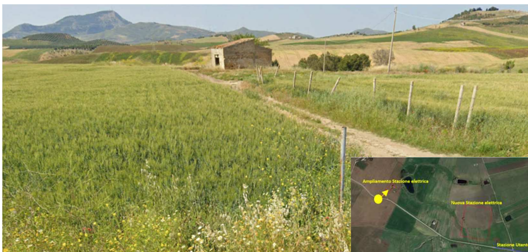
Foto. 32, 33, 34, 35, 36, 37 Stazione utente, nuova stazione di elettrica e ampliamento stazione elettrica
