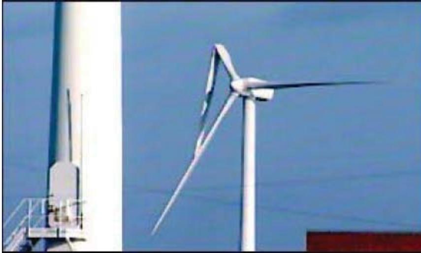
**Esempio di rottura di pala senza distacco.**
