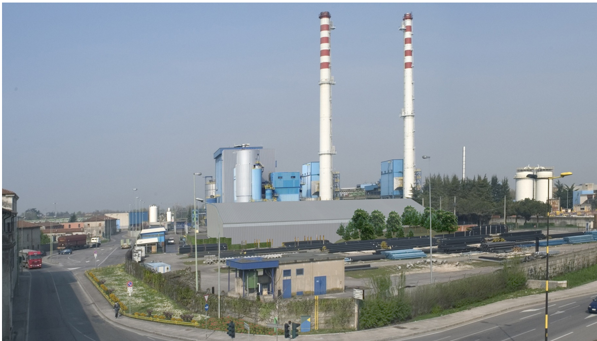
Figura 4: vista da circa 10 m dall'incrocio S.Zeno-Ziziola, con il nuovo edificio e la Centrale alle sue spalle
