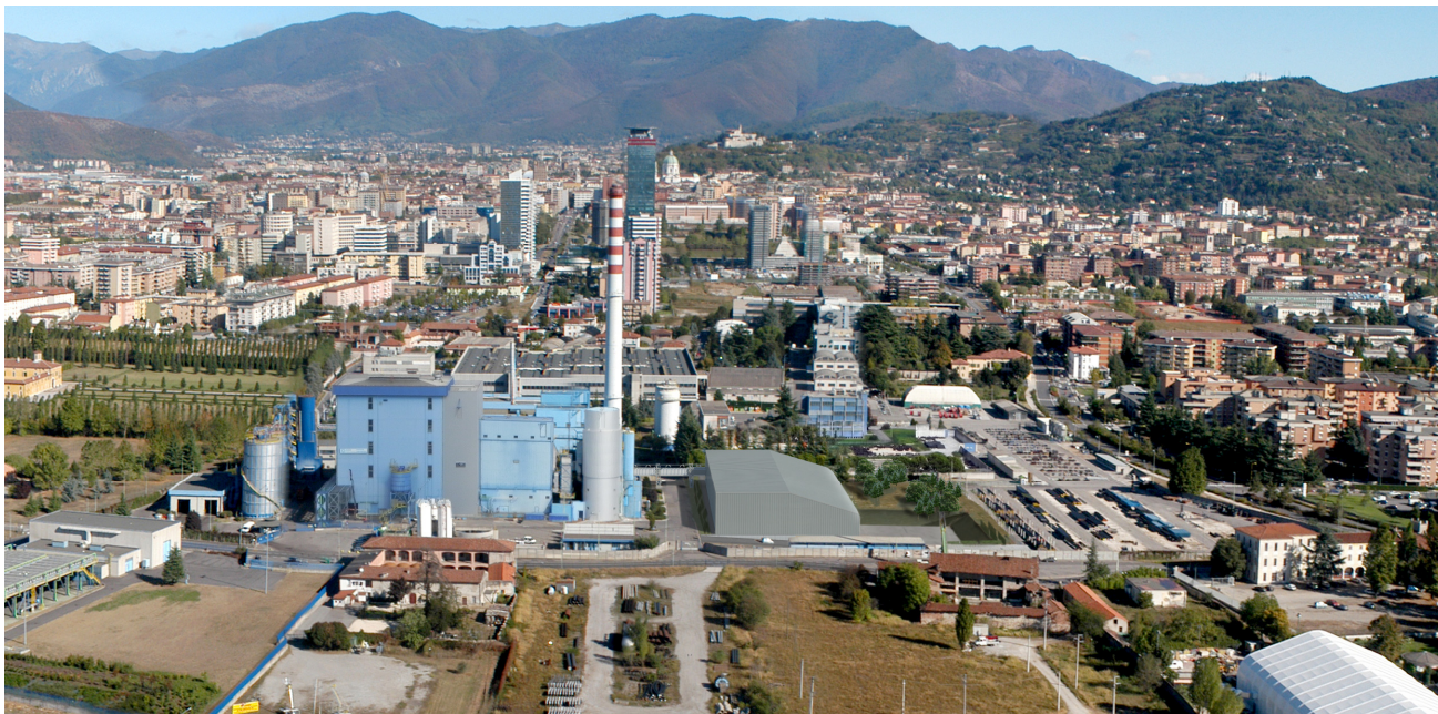
Figura 3: analoga ripresa di figura 2 ma con le trasformazioni recenti ed il nuovo edificio caldaie sulla destra
