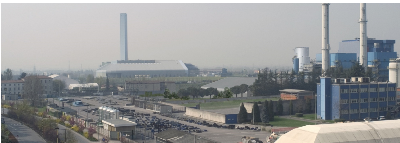
Figura 1: vista da nord-est del nuovo edificio con sullo sfondo il termoutilizzatore
