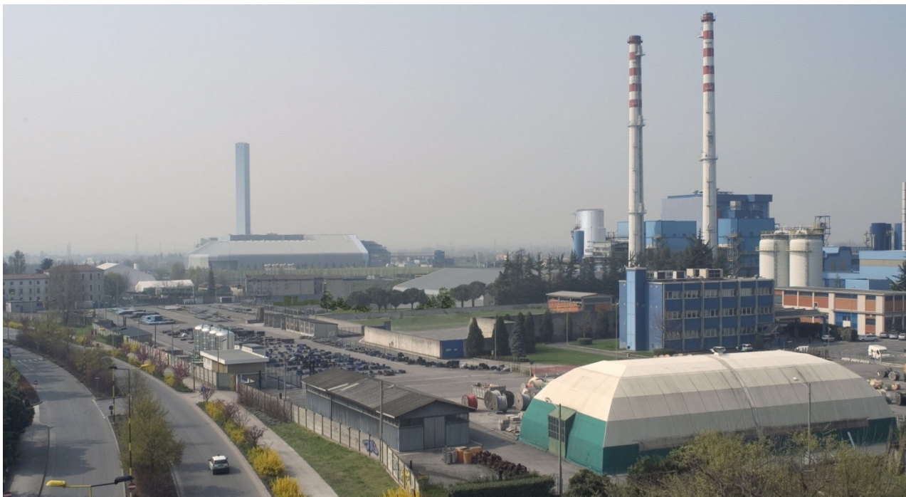
Fig 11 – Vista V5 dell'edificio caldaie con sullo sfondo il termoutilizzatore, dalla via S.Zeno ad altezza di circa 20 m
