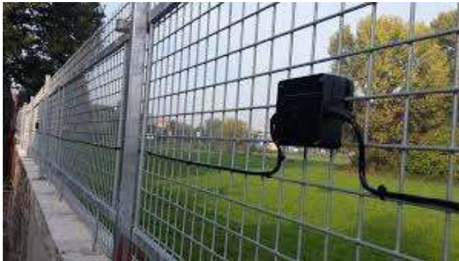
Figura 6 - Tipologico di cavo microfonico
