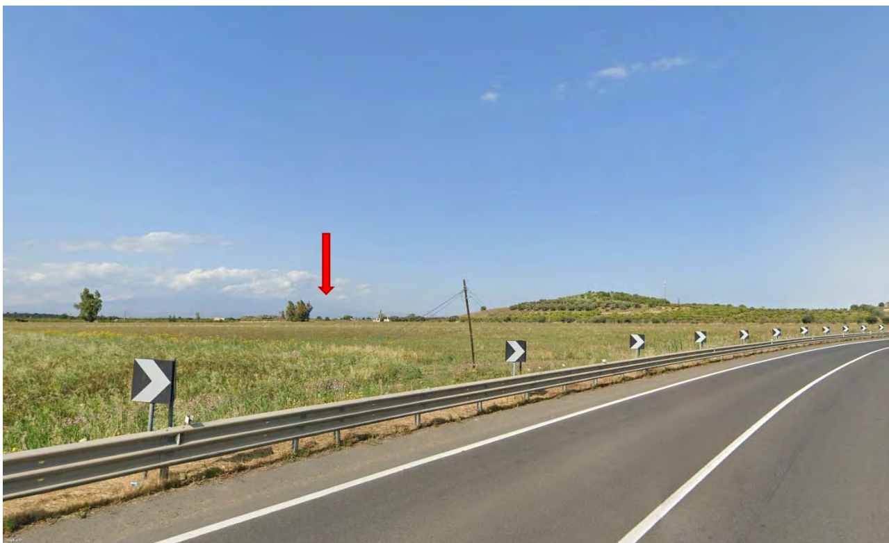
Figura 112 – Foto dal punto n.5 verso l'area di progetto indicata dalla freccia rossa - Fonte: Google Earth
