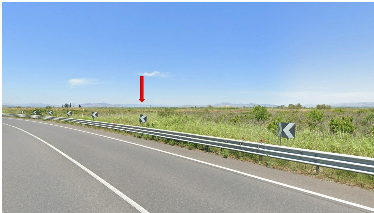
Figura 28: Punto di vista n.3 – SS417
