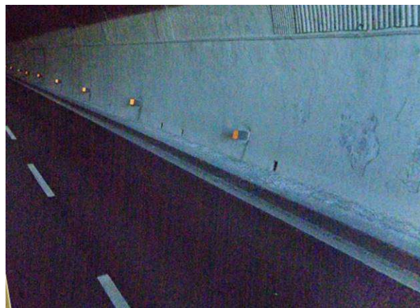
Figura 4-8 – Feritoie relative a probabili scarichi di sistemi drenanti perimetrali.
