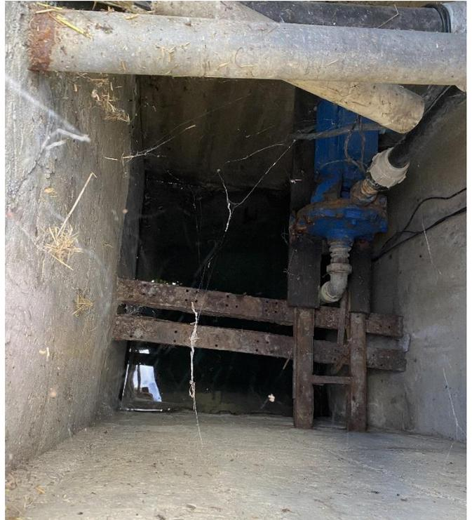
**Figura 23 – Sorg 01 impianto di pompaggio interno all'opera di presa.**
