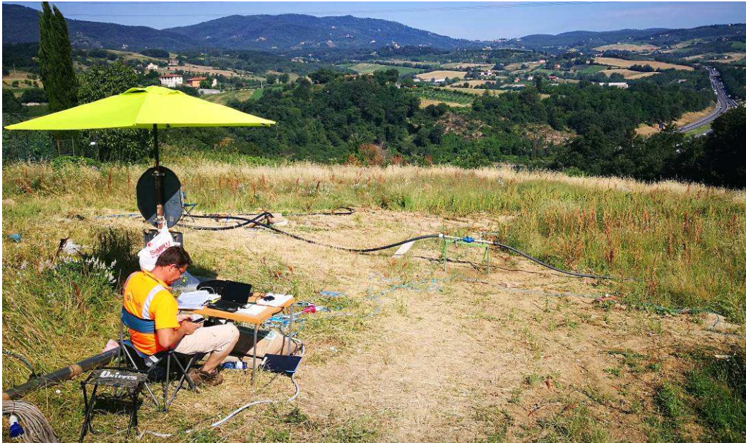
Figura 33 - Allestimento per la prova di emungimento di lunga durata (72 ore) sul pozzo; sul tubo di mandata è riconoscibile il contatore per il controllo della portata in emungimento.
