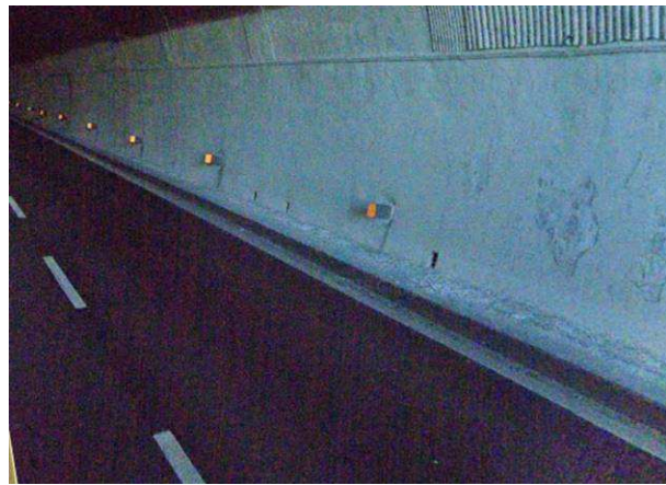
Figura 14 – Feritoie relative a probabili scarichi di sistemi drenanti perimetrali.
