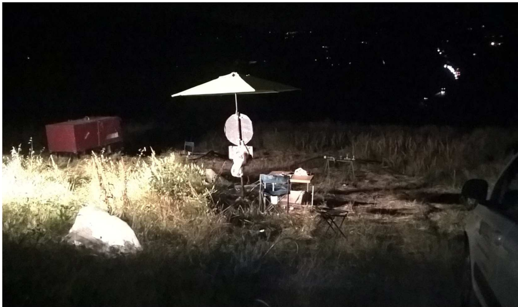
Figura 34 - Allestimento per controllo notturno della prova di emungimento di lunga durata a sinistra dell'immagine è riconoscibile il gruppo elettrogeno per l'alimentazione dell'elettropompa sommersa.
