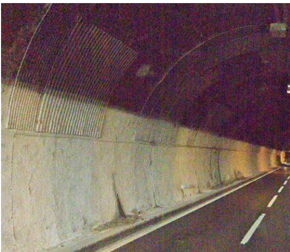
Figura 11 – Centinatura e aloni di umidità in corrispondenza dei piedritti della canna Nord a circa 280 m dall'imbocco lato Roma.
