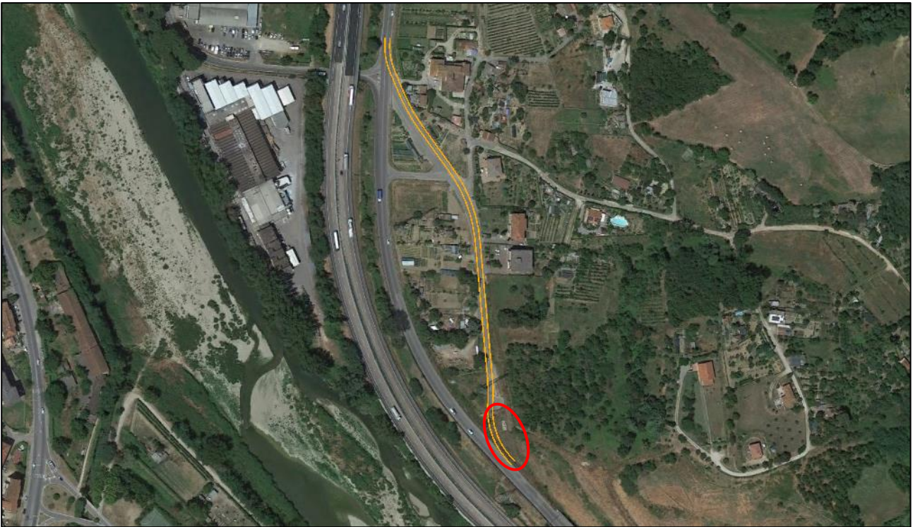
Figura 5-5 Immagine d'inquadramento della viabilità di servizio VS08, in perimetro arancione (il perimetro rosso individua l'ambito oggetto di ripristino)
