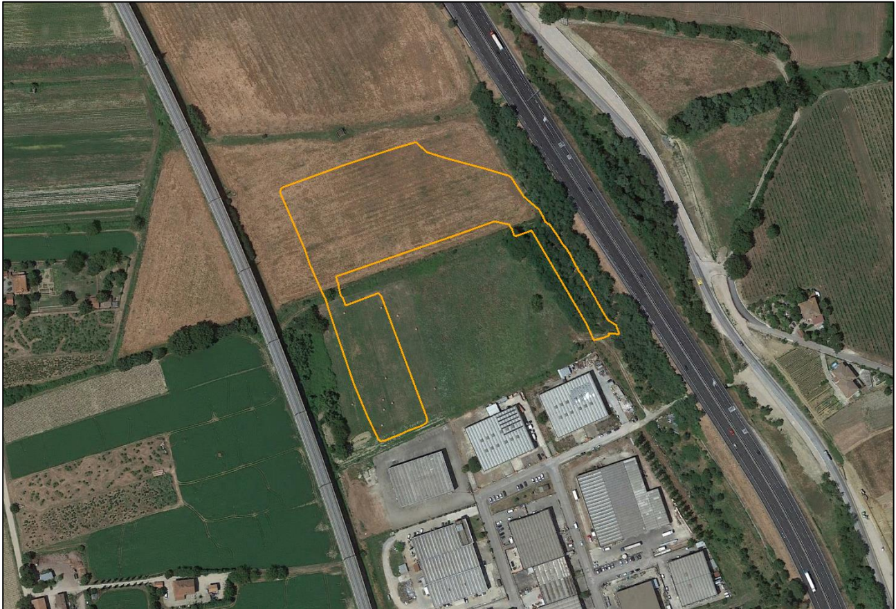
Figura 5-2 Immagine d'inquadramento dell'area di cantiere CO01 (perimetro arancione)
