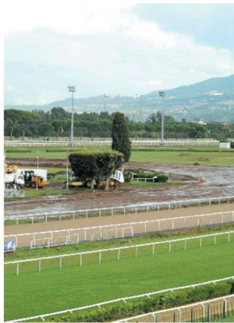
Lavori già iniziati nell'ippodromo per realizzare l'anello alle gare di trotto
