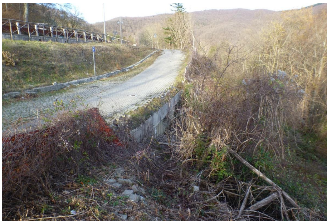
Foto 20b – Cedimento del ciglio del parcheggio in località Monte di Fò a valle della strada S.R.65 (dettaglio 1° punto).
