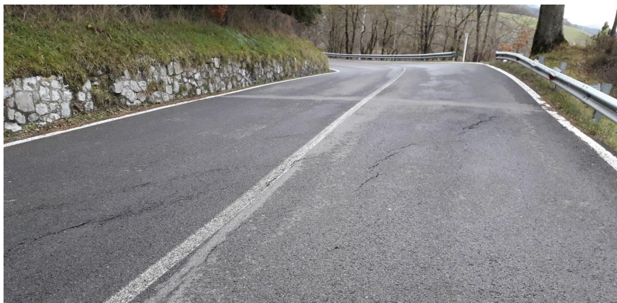
Foto 29 a,b – Lesioni sul manto stradale all'altezza della curva n° 3, indicanti un fenomeno di retrogressione del coronamento della frana attiva (Dicembre 2019).
