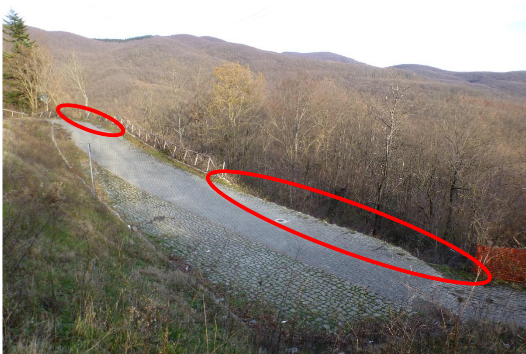
Foto 20a – Cedimenti (nei punti evidenziati in rosso) del ciglio del parcheggio in località Monte di Fò a valle della strada S.R.65 (Dicembre 2021)
