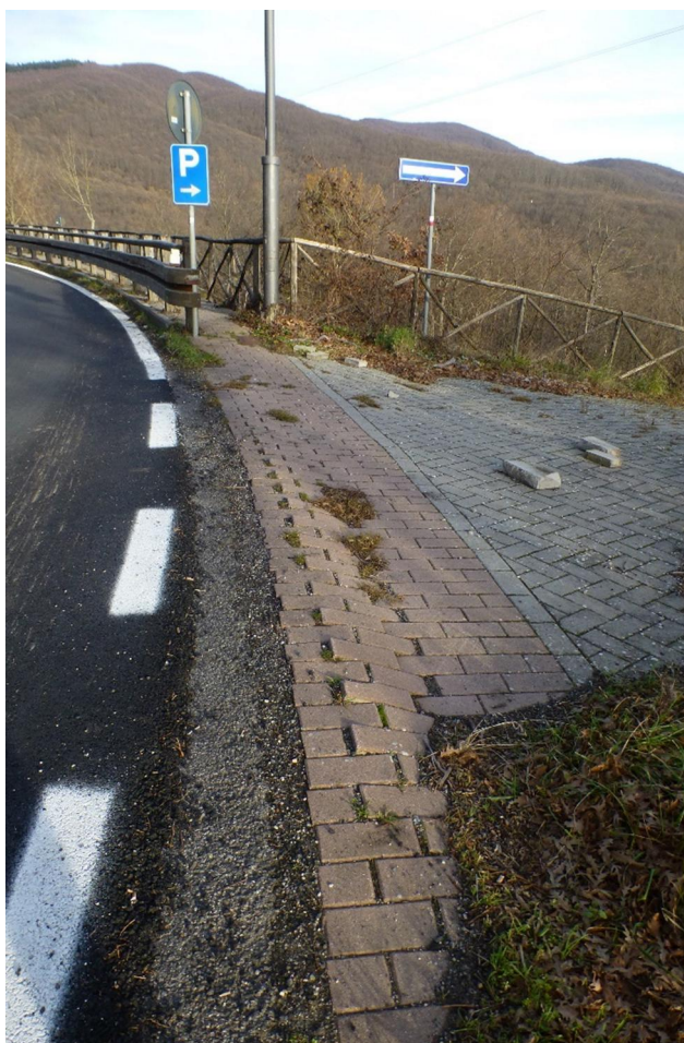
Foto 19 – Fratture al contatto della rampa di accesso al parcheggio con la sede della SR65 (Dicembre 2021).
