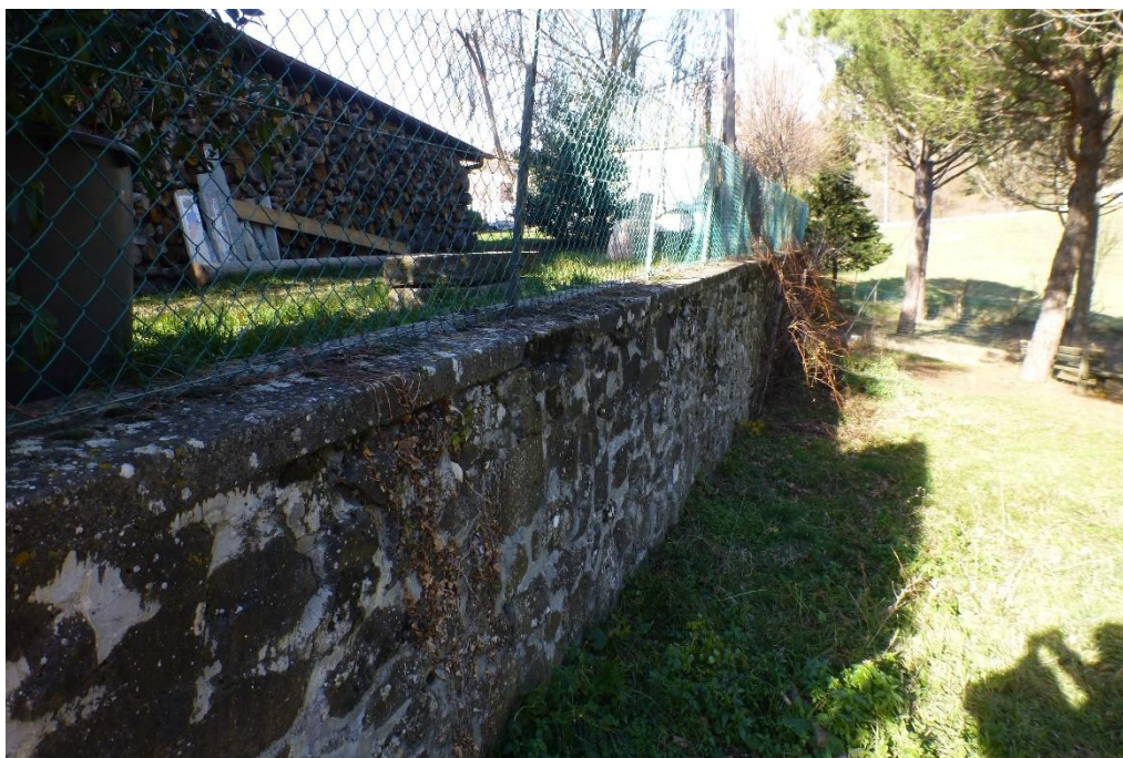
Foto 14 – Muro leggermente ruotato nei pressi del sondaggio FN6 (Dicembre 2021).
