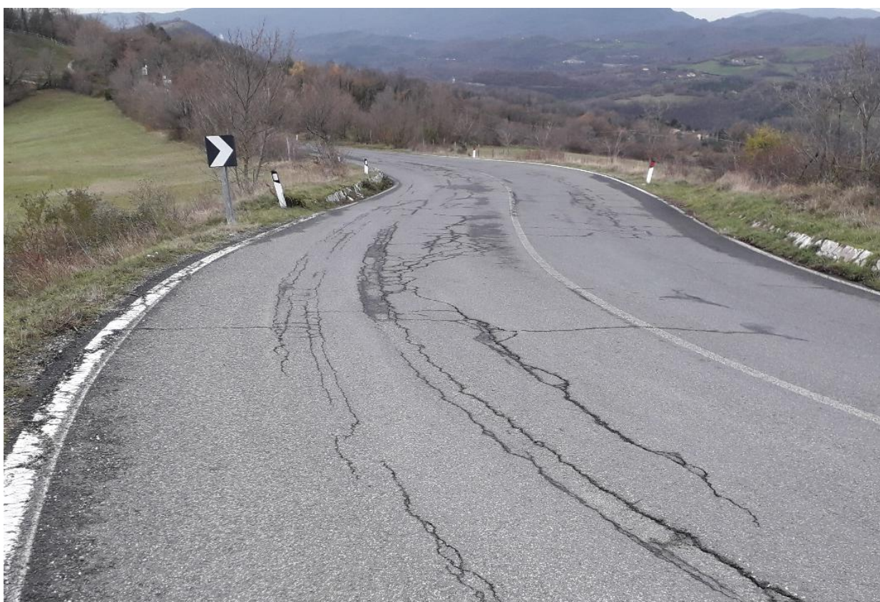
Foto 12 a,b,c– Lesioni nel manto stradale lungo la SR65, nei pressi dell'intervento "Curva I" (da sud a nord, foto Dicembre 2019).
