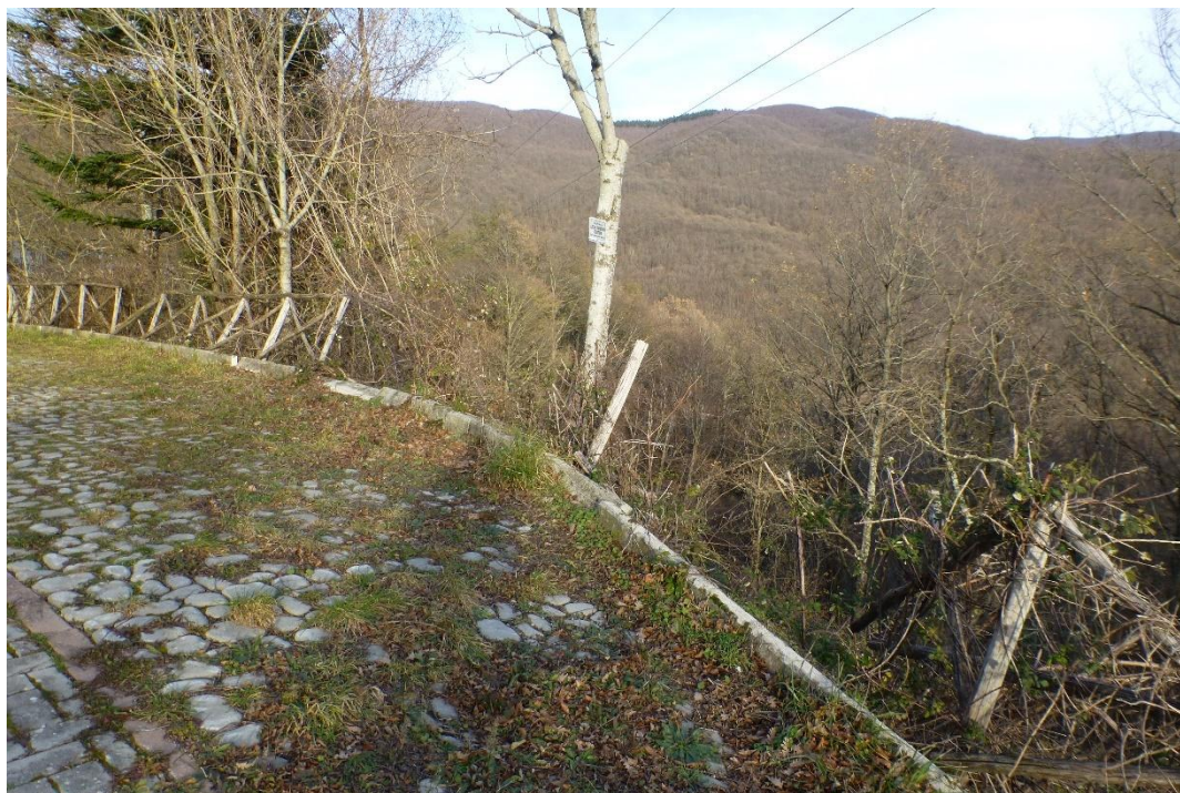
Foto 20c – Cedimento del ciglio del piazzale del parcheggio in località Monte di Fò a valle della strada S.R.65 (dettaglio 2° punto).
