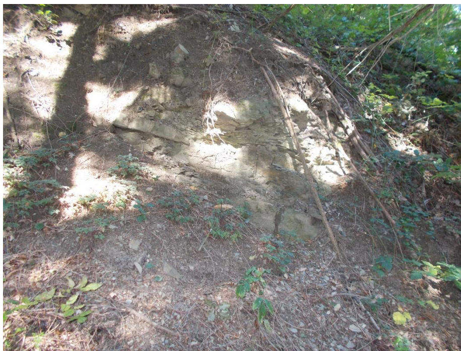
Foto 16 – Affioramento AQR1 al di sotto del vecchio sedime della SR65.
