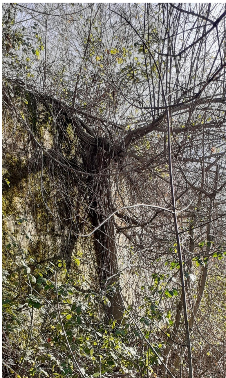
Foto 32 – a) Lesioni sul manto stradale all'altezza del sondaggio SD25 (Dicembre 2019), b) Recente ripristino dell'asfalto all'altezza del sondaggio SD25 (Dicembre 2021), c) Spostamento lungo i giunti del muro stradale di ca. 20 cm all'altezza del sondaggio SD25 (Foto Dicembre 2021).
