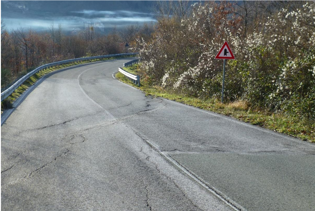
Foto 37 – Settore tra i sondaggi T40-T41: lesioni a forma di lunetta presenti lungo la sede stradale (Dicembre 2019).
