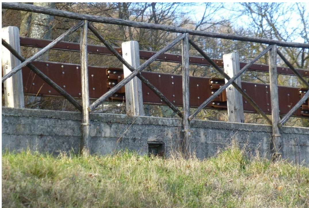
Foto 21 – Testa dei tiranti della palificata superiore a valle della strada S.R.65 (Dicembre 2021).
