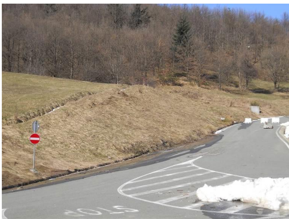
Foto 31 – a) Lesioni stradali all'altezza dello svincolo By-pass di Traversa b) Soliflusso a monte dello svincolo (Foto 2015).
