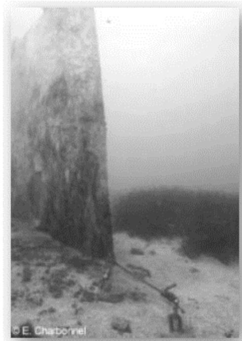
Figura 13 Uno schermo in geotessile (a sinistra) che protegge una prateria di *Posidonia oceanica* (a destra) in un lavoro sottomarino in Francia. (foto E. Charbonnel)
