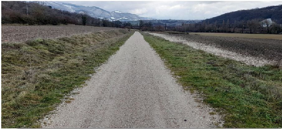
Fig. 3 - strada tipo in misto granulare
