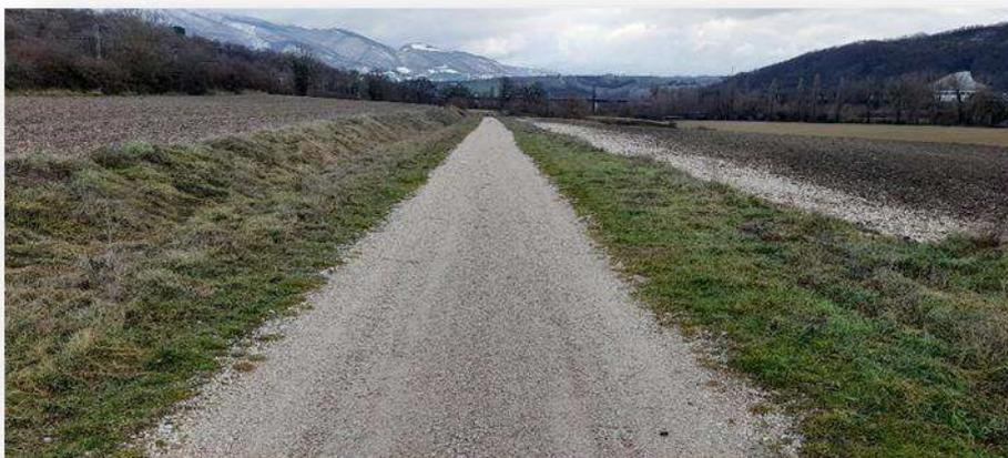
Figura 2 – Esempio di strada tipo in misto granulare
