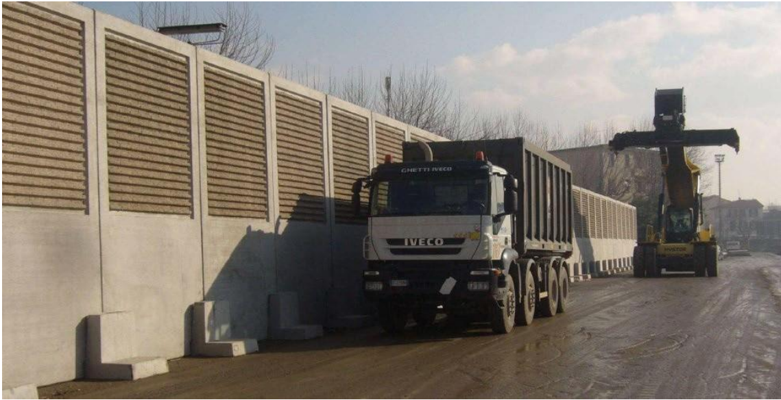
Fig. 5 - immagine di esempio di installazione di una barriera mobile
