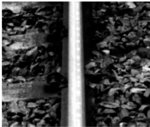
**Figura 1.** Evidente corrugamento della rotaia.
