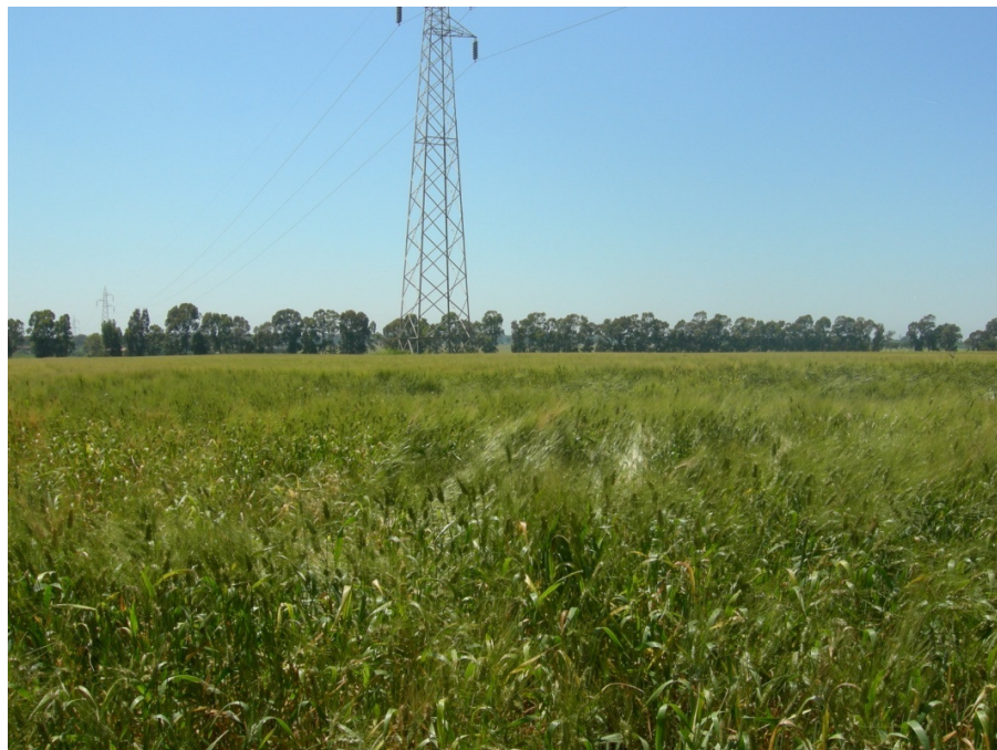
Figura 35: Il.3 panoramica traliccio 16, da via di Dragone
