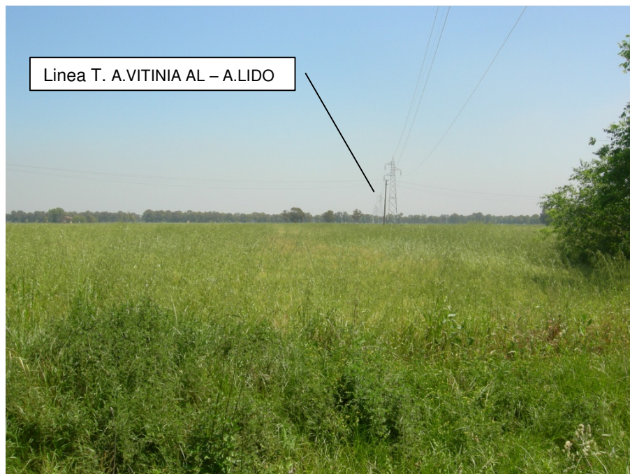
Figura 28: Il.3 panoramica dei tralicci 29, 28 e 27 da via Capo Due Rami (evidenziata la linea oggetto di demolizione)
