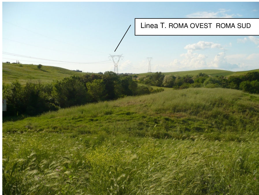
Figura 15: Il.9 panoramica traliccio 4 e 5 (evidenziata la linea in progetto di demolizione)
