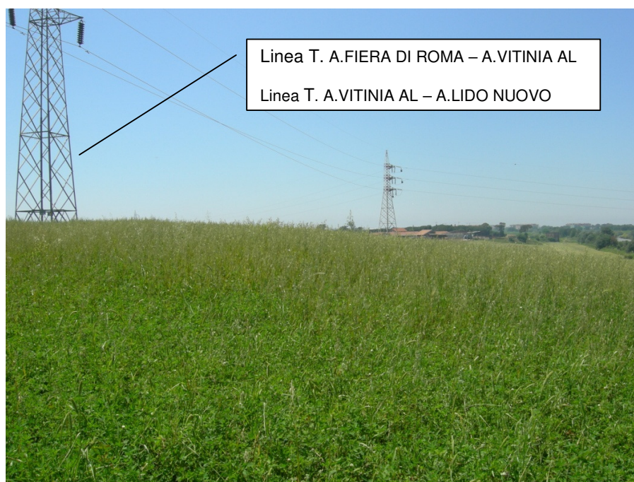
Figura 34: Il.3 panoramica dei tralicci 17 e 18 da via C. Albizzati (2) (evidenziate le linee oggetto di demolizione)
