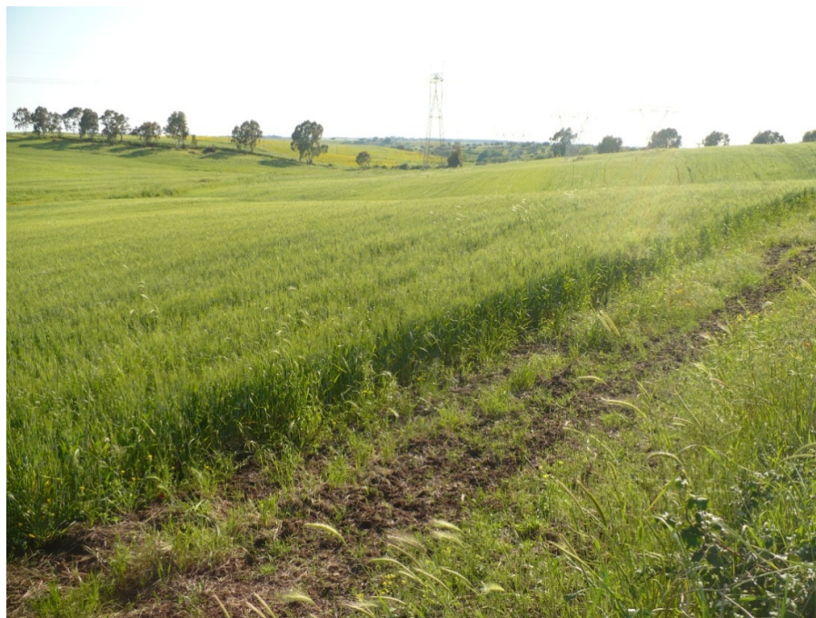
Figura 13: Il.9 ubicazione traliccio 9, coordinate 41°43'6.27"N 12°31'41.70"E
