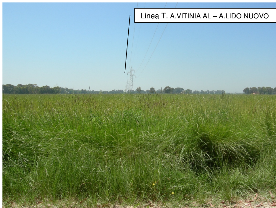
Figura 29: Il.3 panoramica dei tralicci 29, 28 e 27 da via Monti del Sale (evidenziata la linea oggetto di demolizione)
