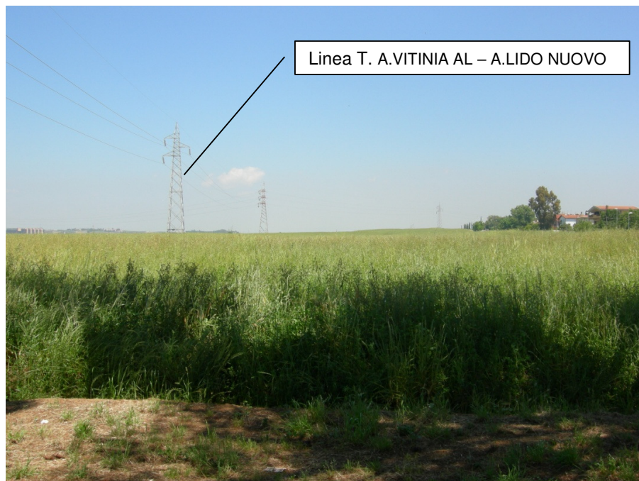
Figura 36: Il.3 panoramica tralicci 13, 14 e 15 da via di Dragone (evidenziata la linea oggetto di demolizione)
