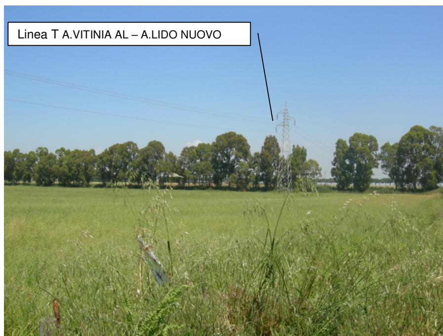
Figura 33: Il.3 panoramica dei tralicci 17 e 18 da via C. Albizzati (1) (evidenziata la linea oggetto di demolizione)
