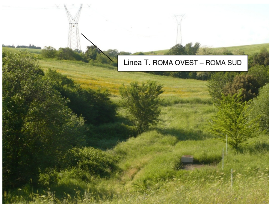
Figura 14: Il.9 panoramica traliccio 5 e 6 (evidenziata la linea in progetto di demolizione)
