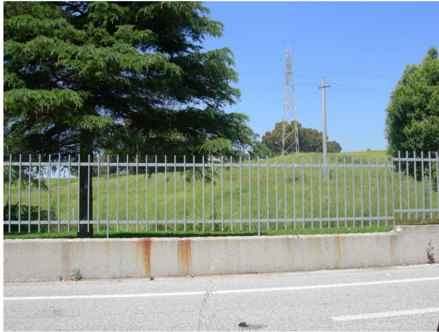
Figura 39: Il.3 panoramica traliccio 11 da via A. Ottaviani
