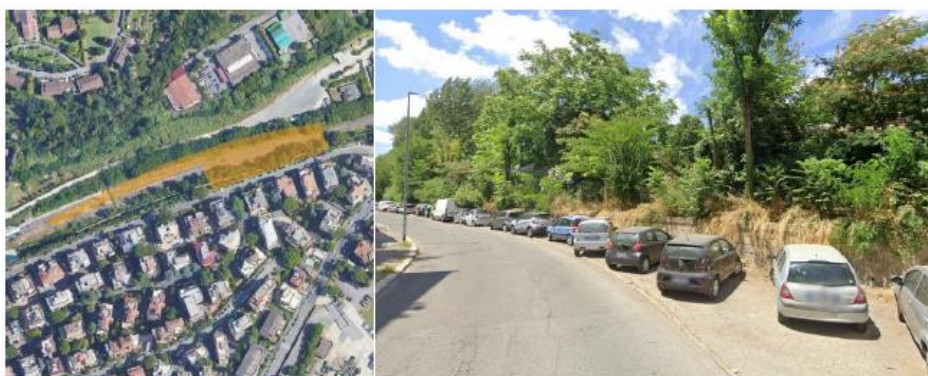
Figura 33 – Area di cantiere AR.02 Tipologia di visuale in territorio urbano con visibilità bassa.
