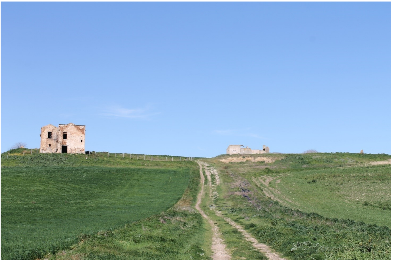
Figura 49: Estratto fotografico in cui si evidenziano due vecchie masserie in stato di abbandono
