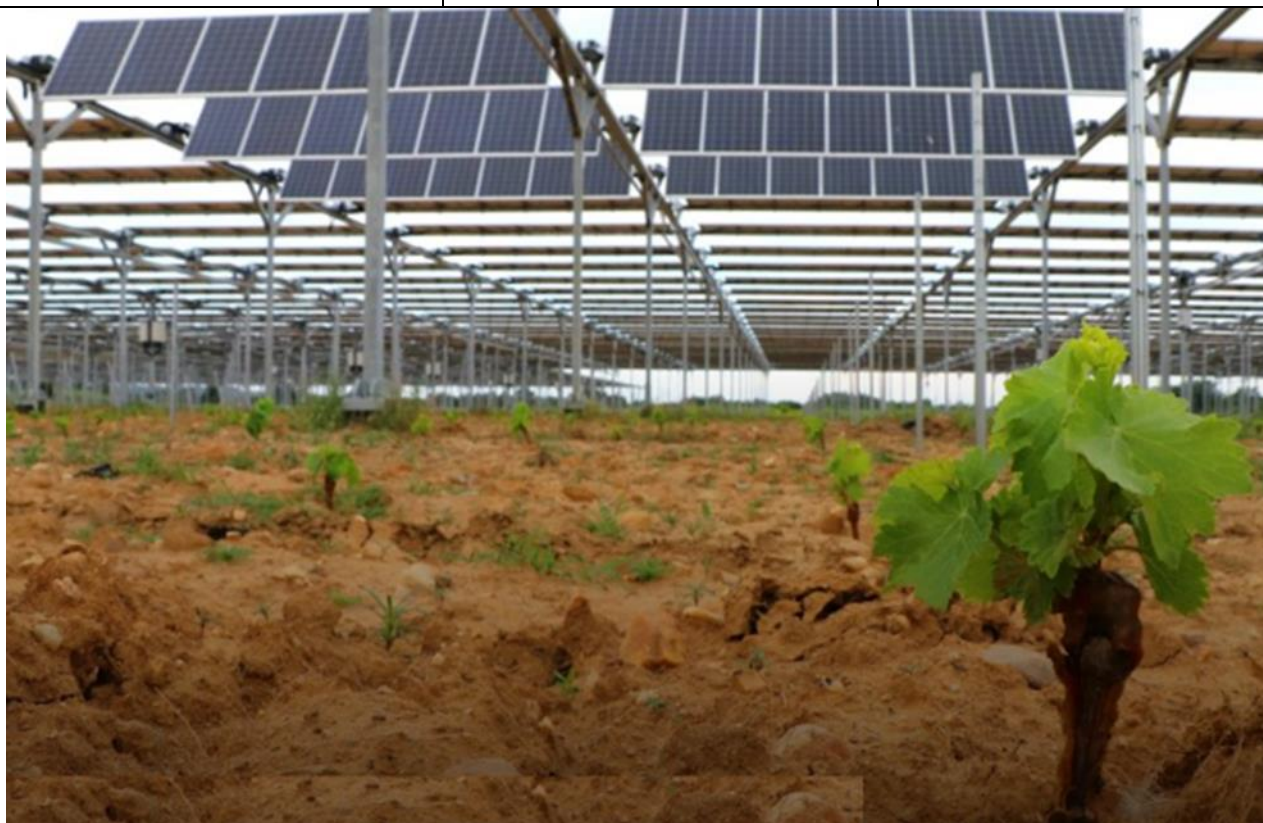
Foto 7 – Un vigneto sotto ai pannelli fotovoltaici.
