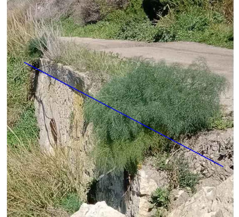
Il tracciato del cavidotto MT di connessione alla rete interferisce con un canale idrico passante ad una profondità di 3,5 m sottostrada.
