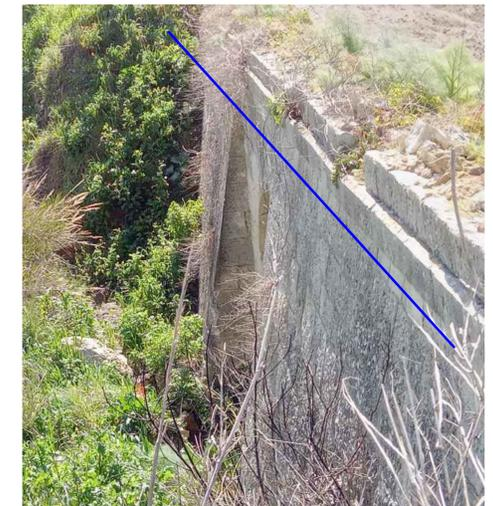
Il tracciato del cavidotto MT di connessione alla rete interferisce con un canale idrico passante ad una profondità di 3,0 m sottostrada.
