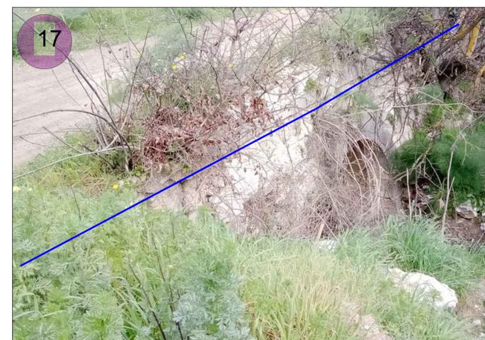
Il tracciato del cavidotto MT di connessione alla rete interferisce con più di un canale idrico. La profondità dei canali idrici è variabile.
