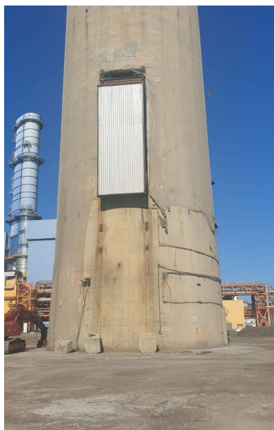
Figure 3 e 4: Bocche di ingresso al camino flangiate cieche.
