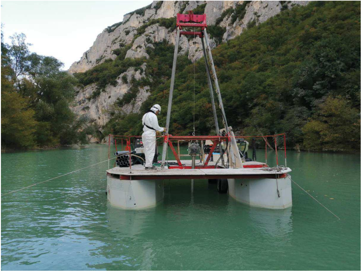
Figura 2-2 Mezzo utilizzato per l'esecuzione dei vibrocarotaggi
