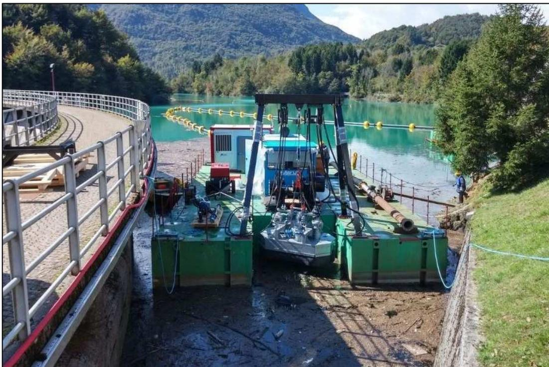
Figura 5-5: esempio di applicazione di un sistema di dragaggio a bacino pieno in un invaso idroelettrico
