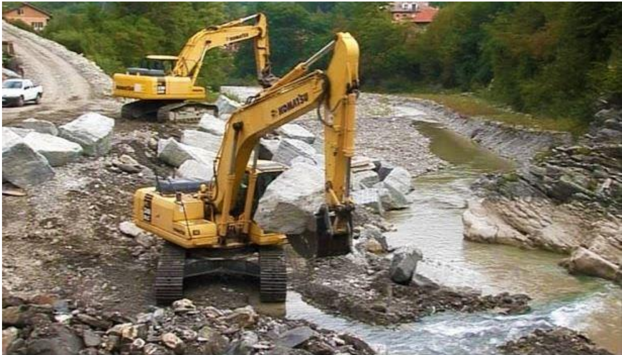
Figura 6.4 - Esempi di attività di scavo in alveo tramite escavatori cingolati a braccio rovescio
