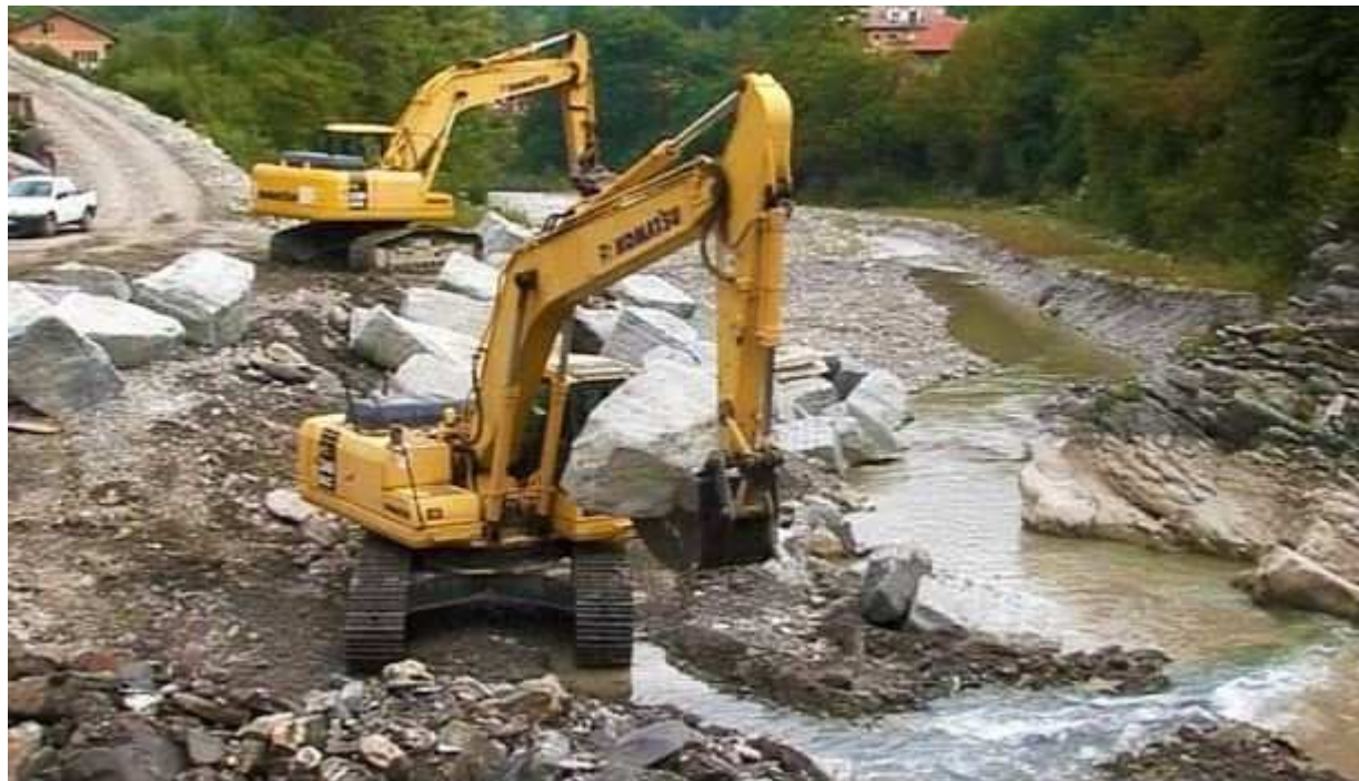
Figura 4-4: esempi di attività di scavo in alveo tramite escavatori cingolati a braccio rovescio
