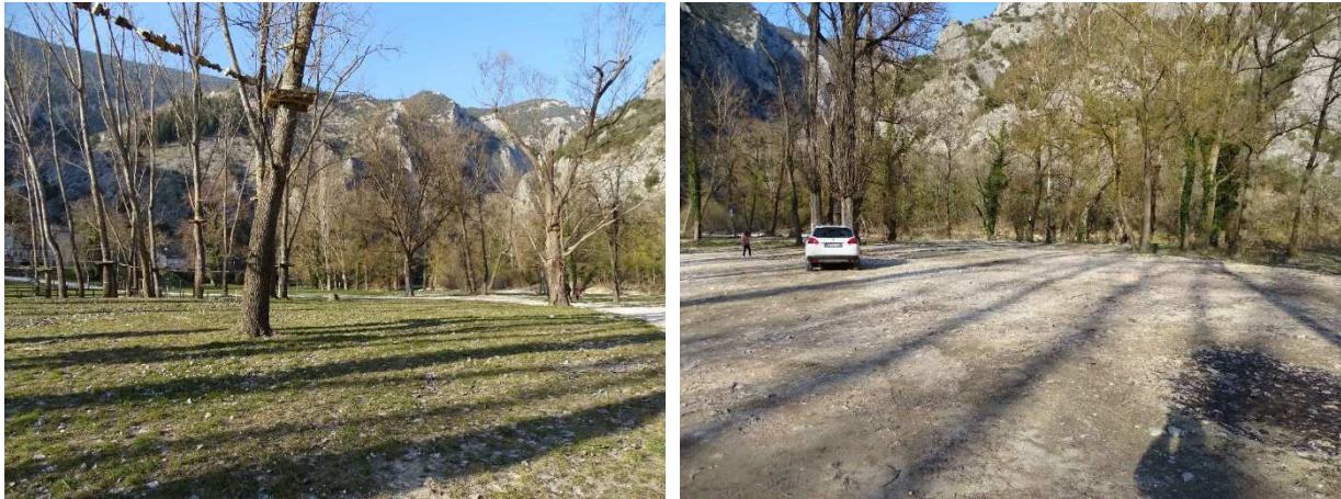
Figura 4-3: rappresentazione dell'area di cantiere in corrispondenza del parco sospeso (foto a sinistra) e dell'area ripariale (foto a destra)
