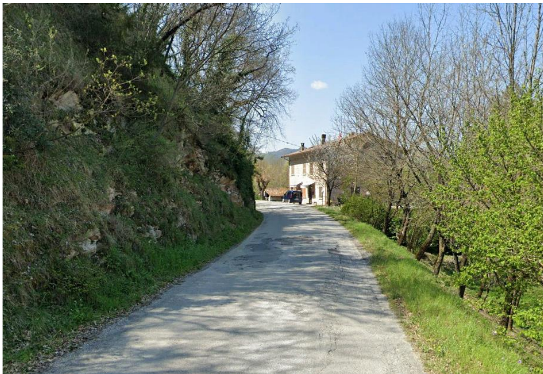
Figura 3.10 – Cedimento stradale lungo al SP 111
