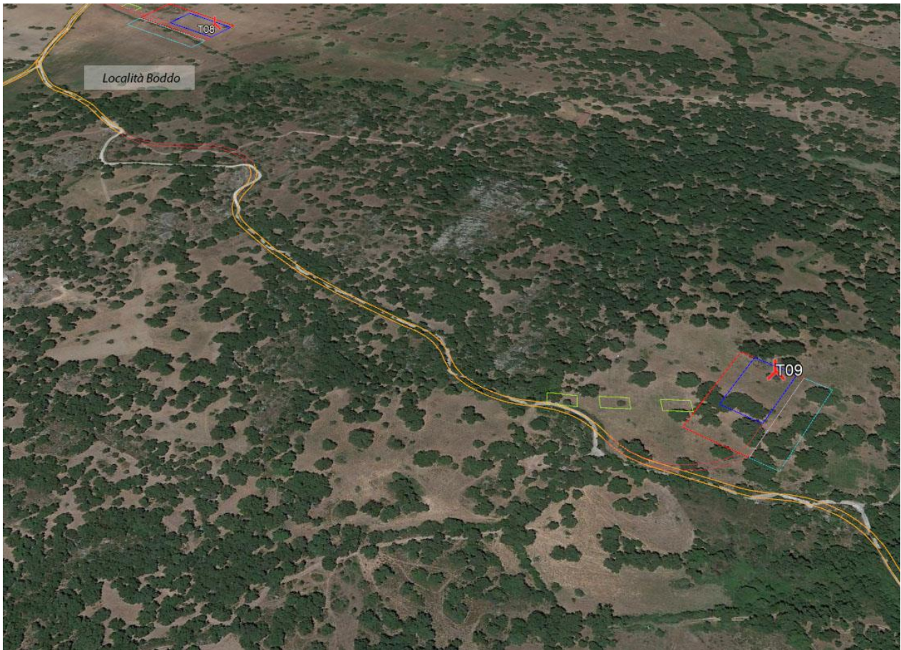
Figura 5.29 – Tracciato in adeguamento e di nuova costruzione di collegamento alla postazione eolica T09 (vista verso nord-est)
