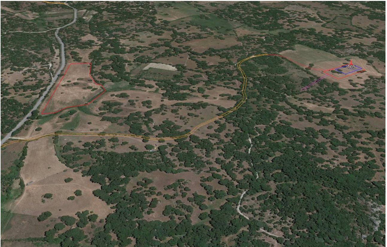
Figura 5.10 – Tracciato di collegamento alla postazione eolica T05 (vista verso nord-est).
