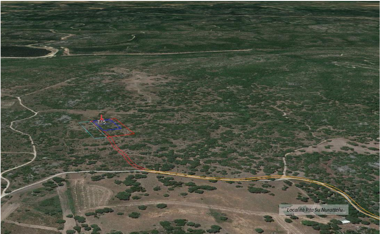
Figura 5.42 – Tracciato di collegamento alla postazione eolica T15 (vista verso sud).
