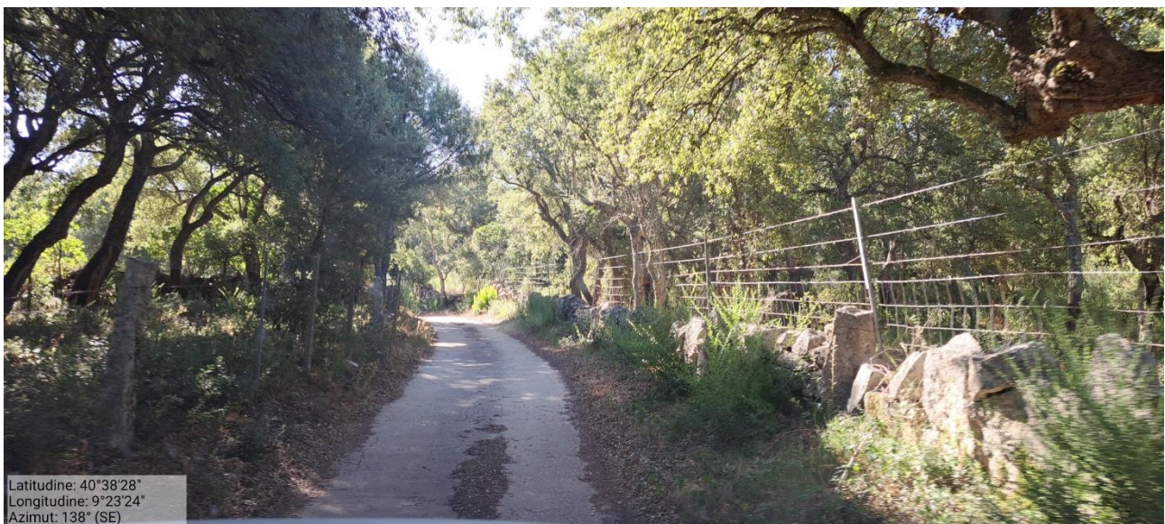
Figura 5.17 – tratto campestre interessato dalla viabilità in progetto di accesso alla postazione eolica T07 (direzione sud-est).
