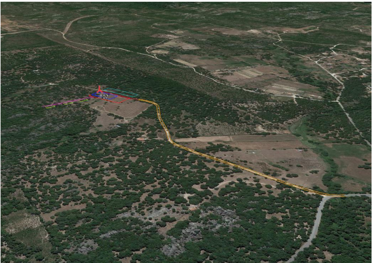
Figura 5.15 – Asse di collegamento alla postazione eolica T07 (vista verso nord-est)
