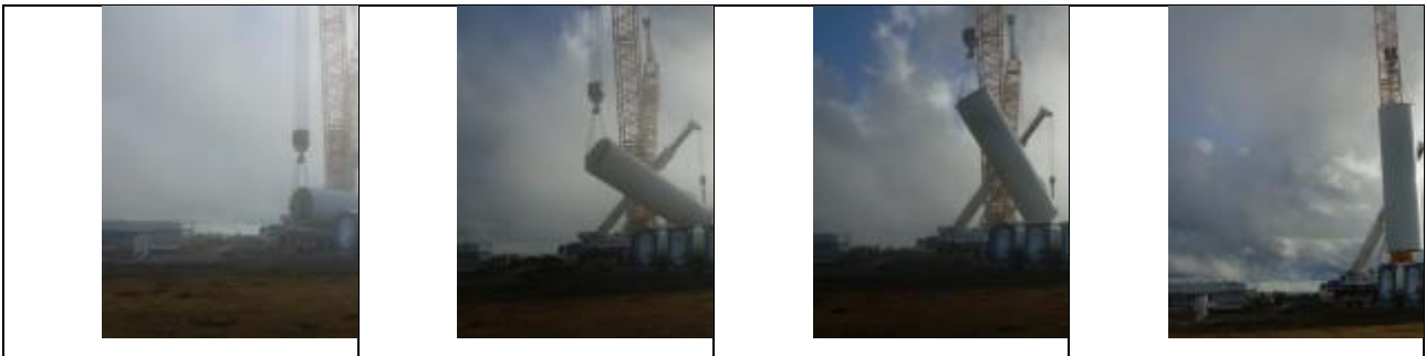
Figura 5.65 – Schema delle fasi di sollevamento dei componenti dell'aerogeneratore (Fonte sito web http://www.windfarmbop.com/ )
