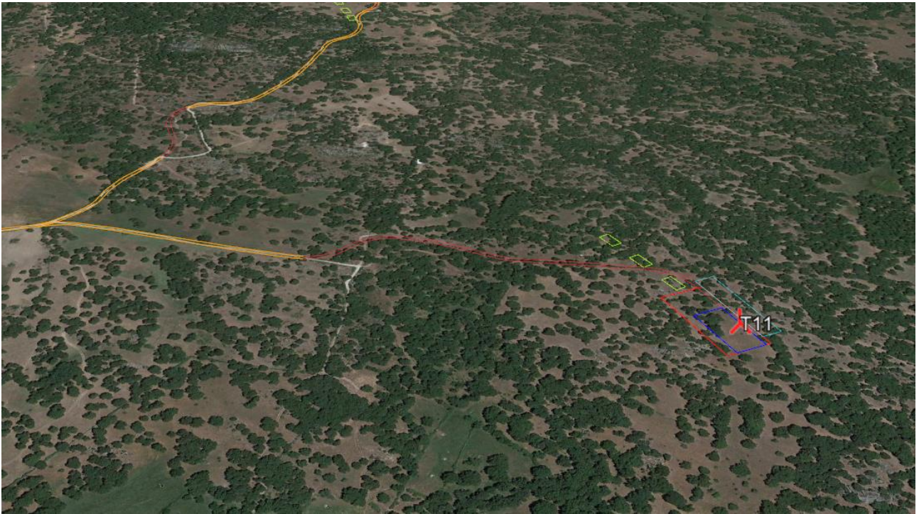
Figura 5.26 – Asse di accesso alla postazione eolica T11 (vista verso est)
