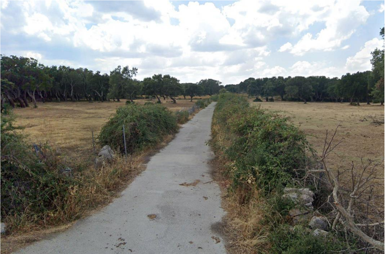
Figura 5.28 – Viabilità da adeguare di collegamento alla postazione eolica T11 (direzione sud)
