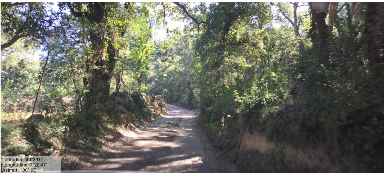
Figura 5.21 – Strada campestre da adeguare di accesso alla postazione eolica T03 (direzione est).
