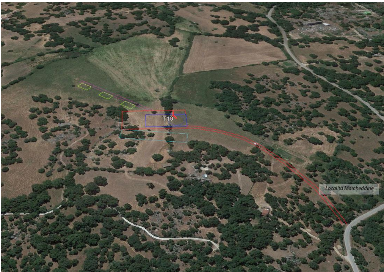
Figura 5.47 – Tracciato di collegamento alla postazione eolica T10 (vista verso sud-est)
