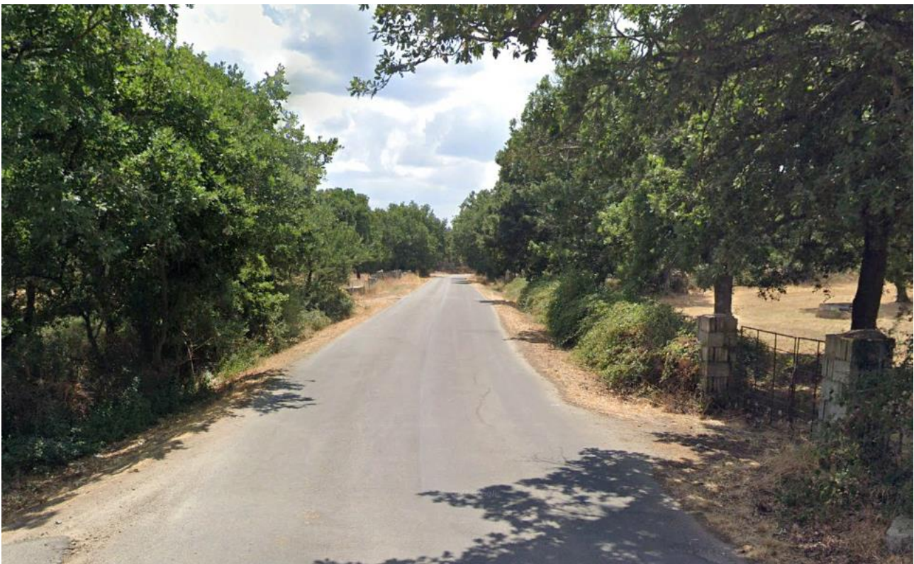
Figura 5.46 - Strada campestre rurale denominata Lathari- Coiluna di collegamento alla postazione eolica T10 (direzione sud)
