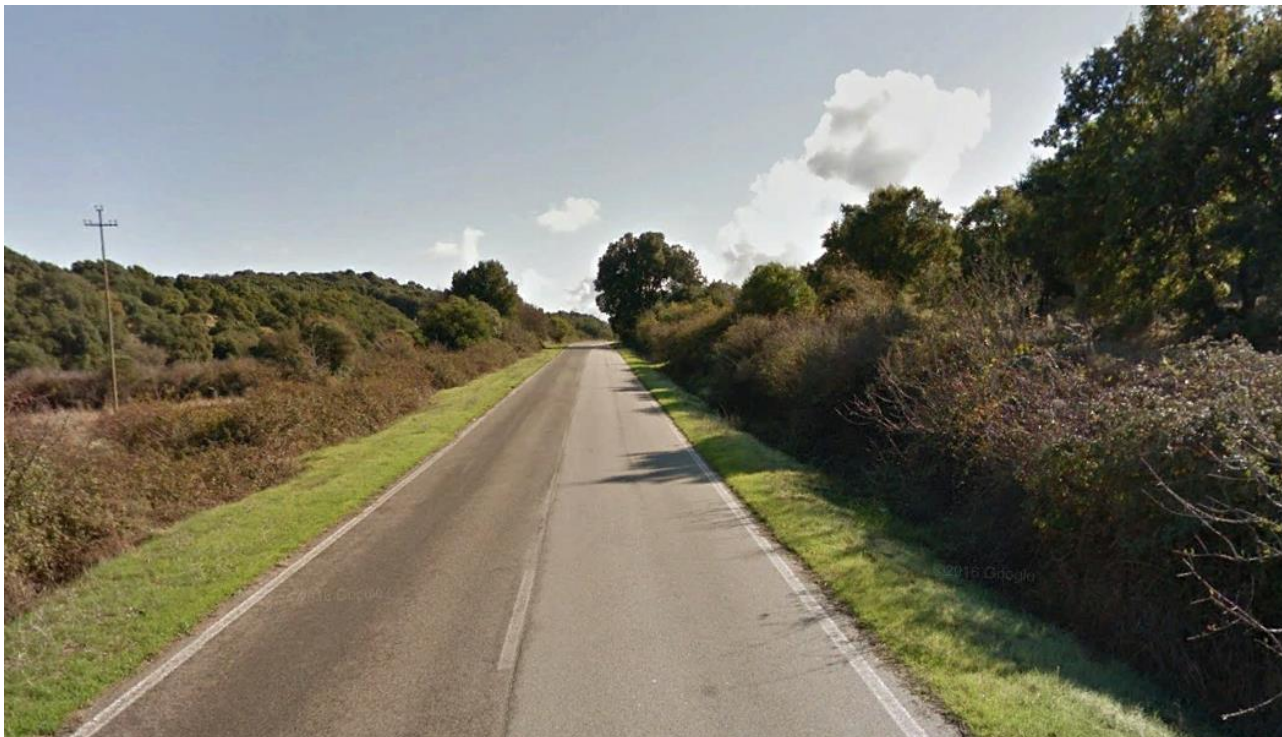
Figura 5.4 – Tracciato della viabilità principale SP 95 di accesso al Cluster Nord-Est – Filatorra (direzione nord-est).
