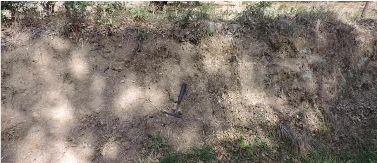
Figura 2.3 – Coltre eluvio-colluviale su taglio stradale.
