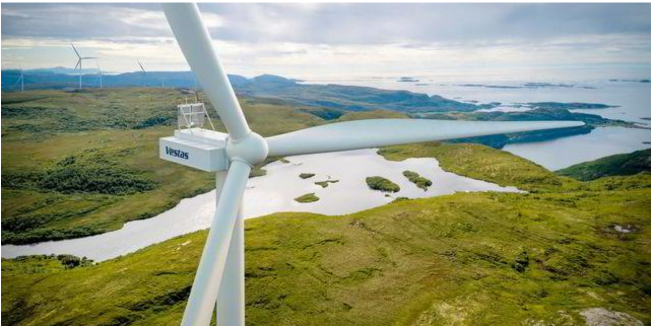
Figura 3.1 - Aerogeneratore Vestas Enventus
