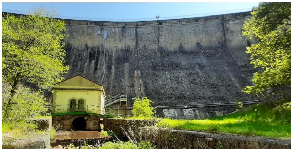
Figura 8: vista del paramento di valle della diga
