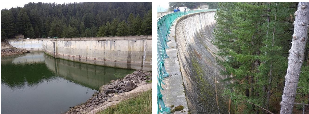
Figura 7: sinistra: vista del paramento di monte; destra: vista del paramento di valle
