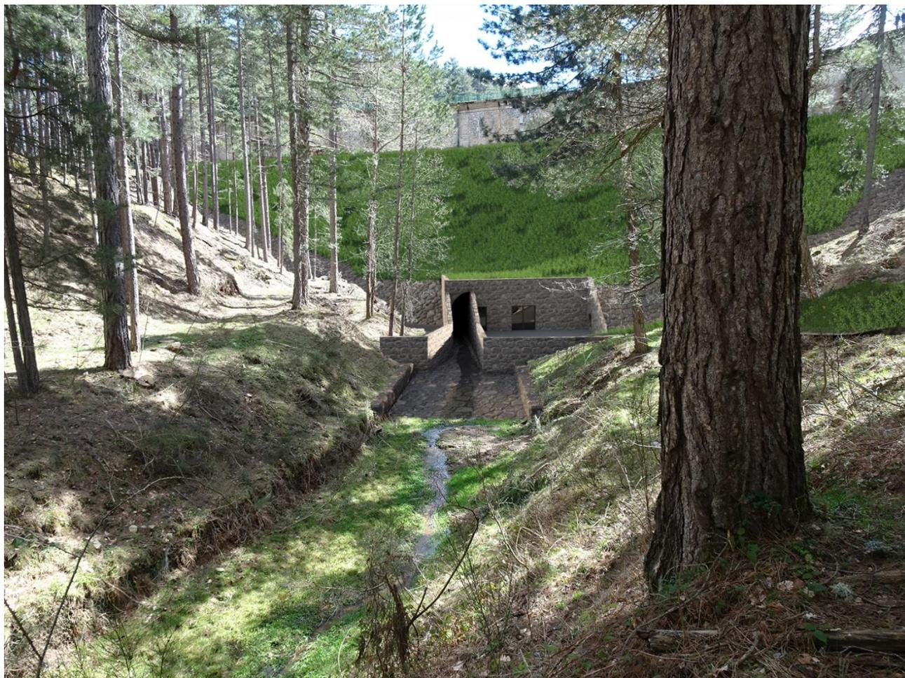
**Figura 112: fotosimulazione del nuovo rilevato in materiali sciolti con copertura in terreno vegetato e pietrame al piede, nuova cabina di comando delle paratoie dello scarico di fondo, uscita dello scarico di fondo e fondo alveo in pietrame (elaborato 10320-C-OR-DTR-A-DS-418)**
