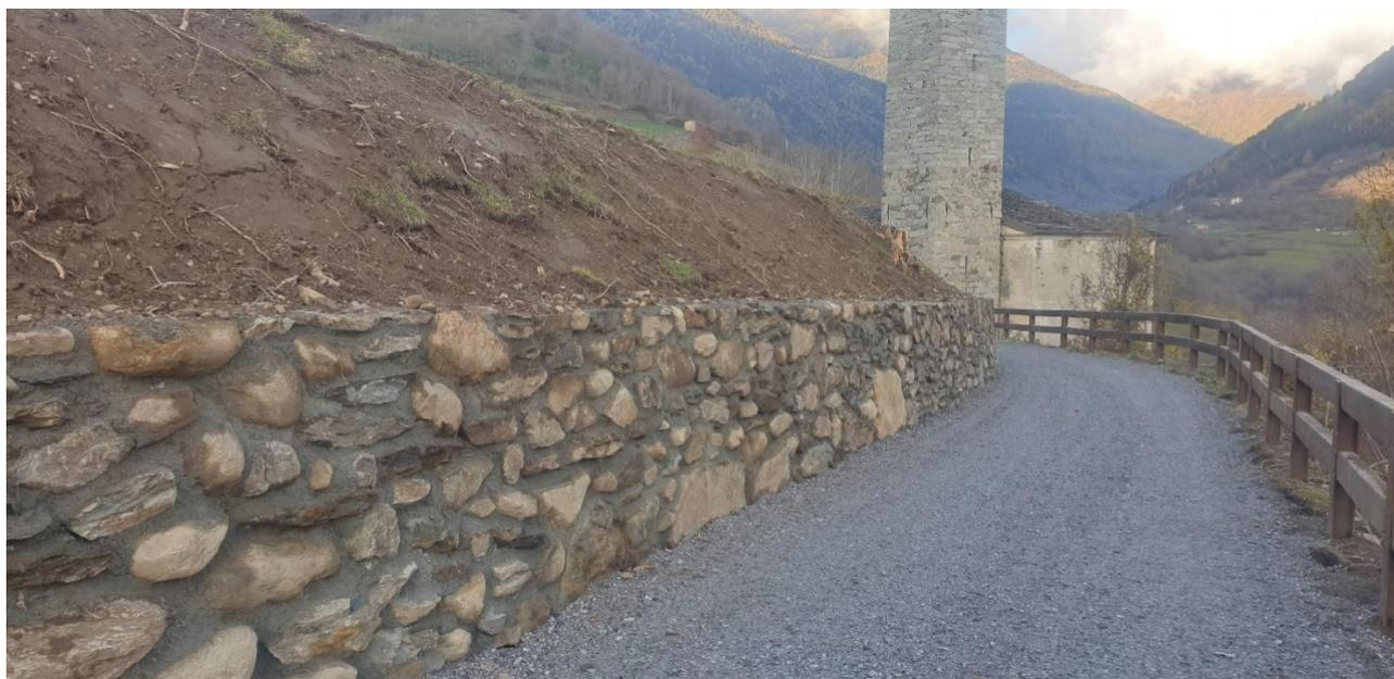
**Figura 113: esempio realizzativo di una strada con pavimentazione in misto stabilizzato**
