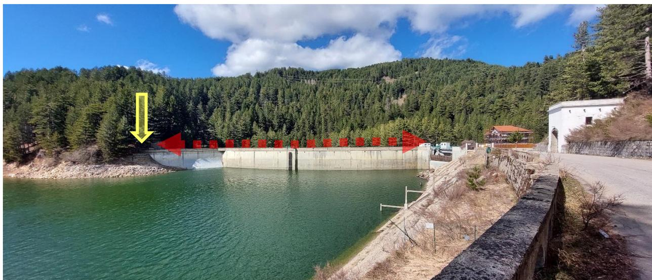
Figura 104: immagine fotografica dello sbarramento principale e secondario ripresi dalla SP35, la freccia gialla indica il piazzale dove si prevede il posizionamento di una cisterna per l'acqua e di un silos per il cemento, la freccia rossa indica il coronamento della diga lungo la quale avverrà il posizionamento di mezzi e macchinari
