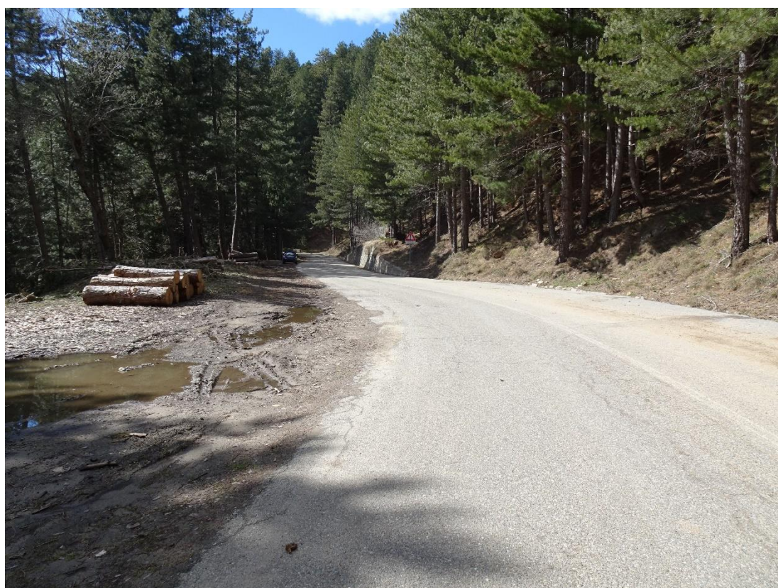
Figura 18: imbocco su strada provinciale
