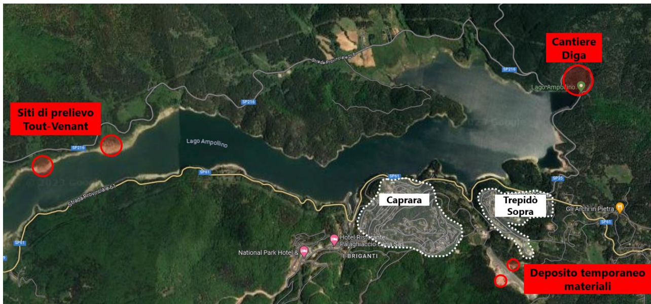
Figura 4: Immagine satellitare del lago Ampollino: in rosso sono indicate le principali aree di lavoro, in bianco gli insediamenti abitativi più vicini alla diga.
