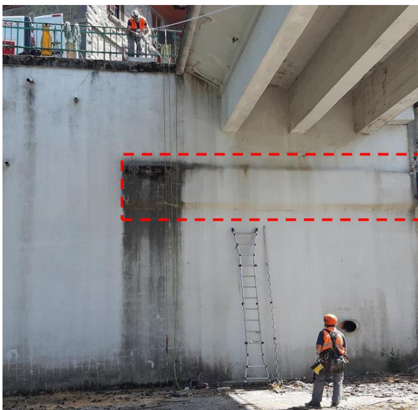
Figura 3 – Muro di sostegno dello sfioratore – Elementi orizzontali in rilievo
