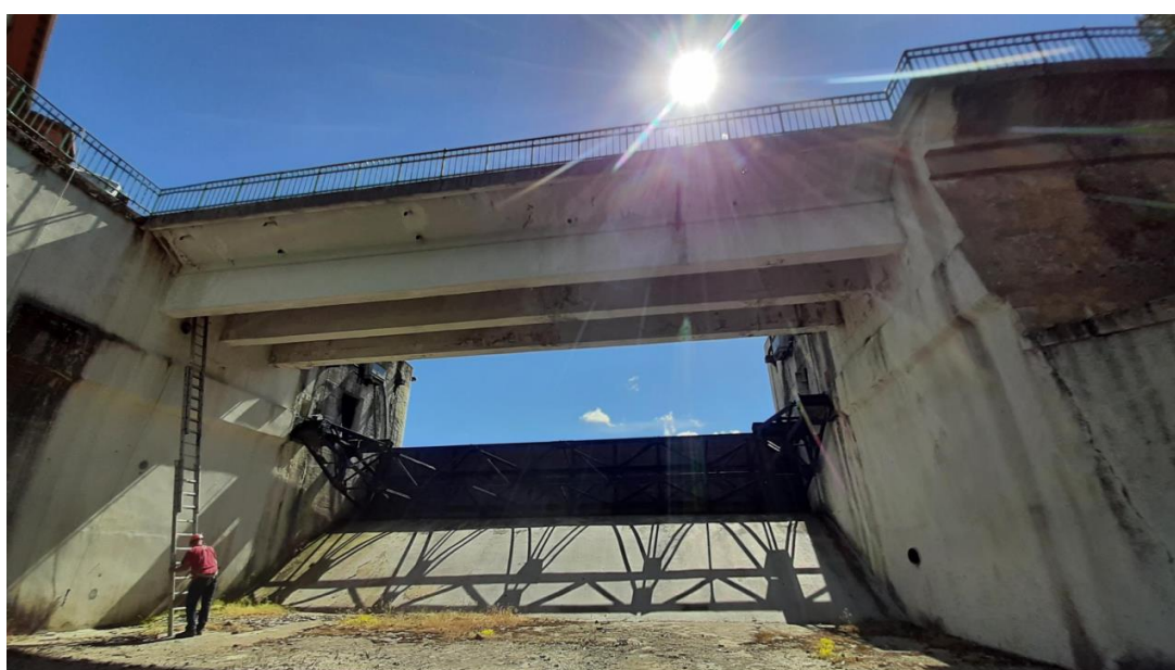
Figura 2 – Ponte sullo sfioratore e muro di sostegno (a sinistra)
