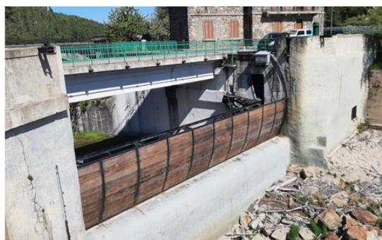
Figura 3-11 – Diga di Trepidò, scarico di superficie [6]
