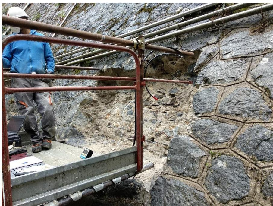
Figura 8 – Foto del paramento di valle rivestito in bognini. Particolare della rimozione di una porzione di rivestimento in bognini per l'esecuzione di indagini in sito
