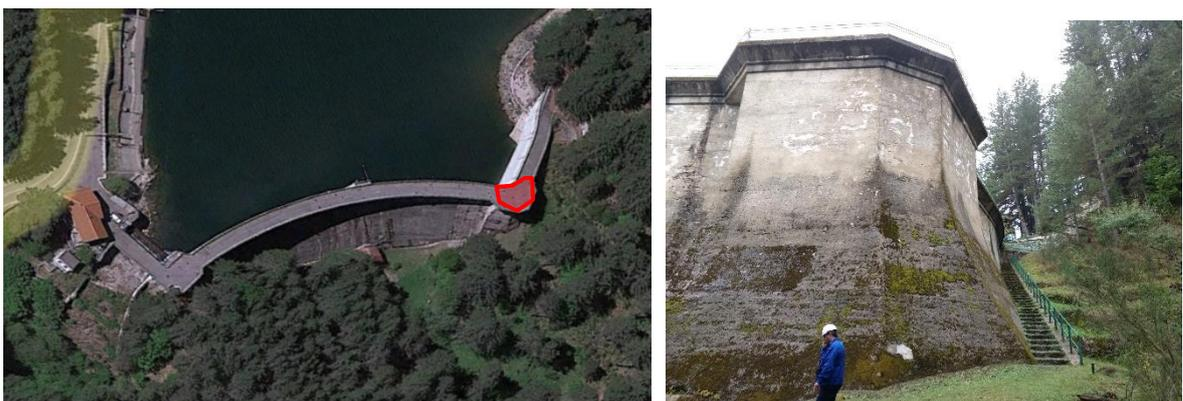
**Figura 13 – A sx: Vista dall'alto della diga; A dx: Foto del pilone-spalla in sponda sinistra con la scalinata di accesso pedonale**
