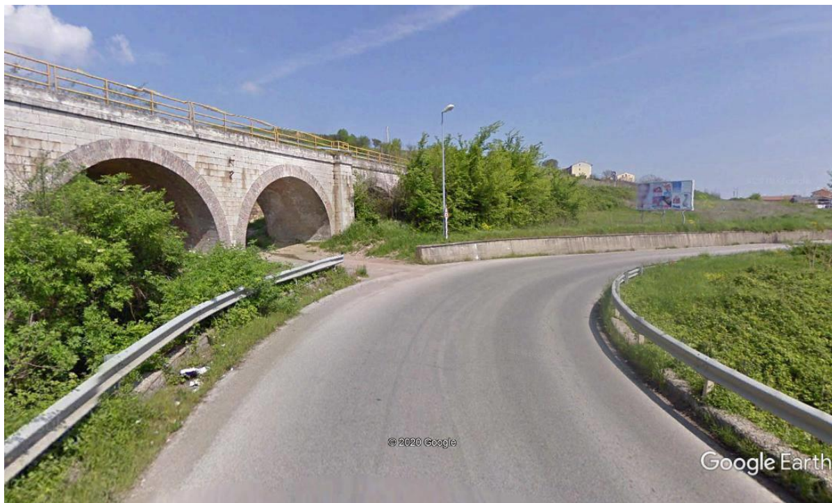
Figura 77 – Stato di fatto accesso al fabbricato al km 73+000
