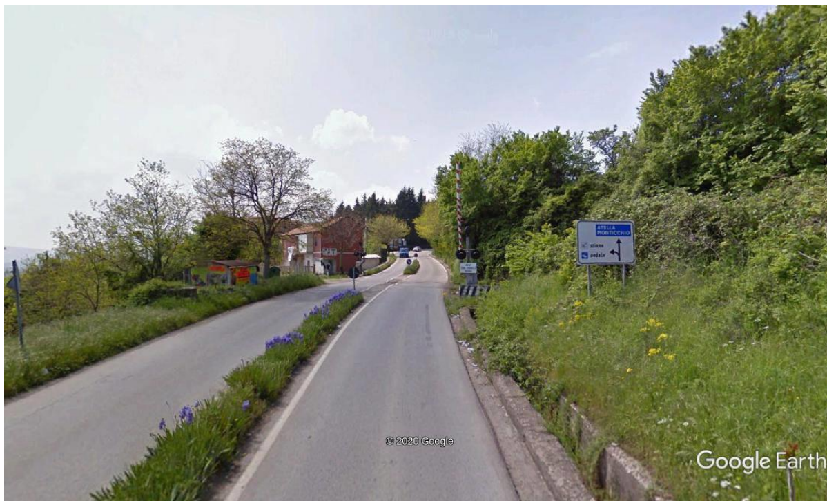
Figura 75 – Vista da ex SS93 del Passaggio a Livello esistente e dell'intersezione tra ex SS93 e Via Padre Pio
