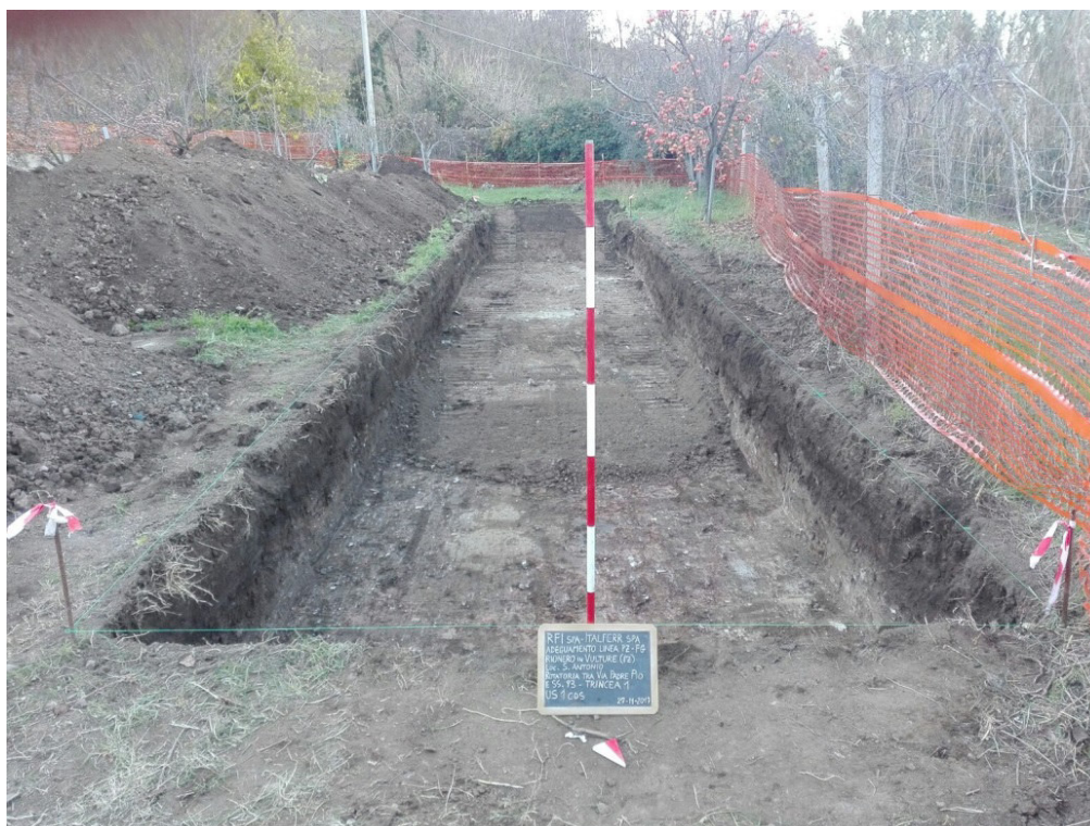
Figura 10 – Trincea 1. Panoramica in corso di scavo
