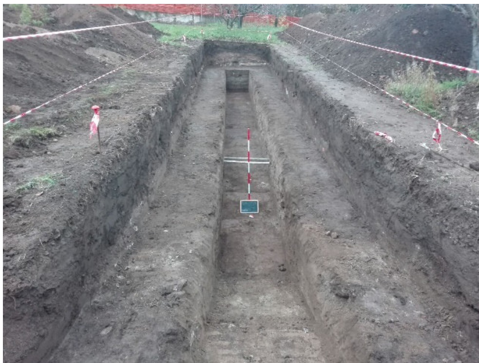
Figura 12 – Trincea 2. Panoramica in corso di scavo
