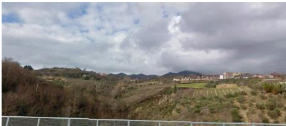
Figura 80 - Vista verso l'area di intervento dalla SS 658 (fonte: Google Earth)
