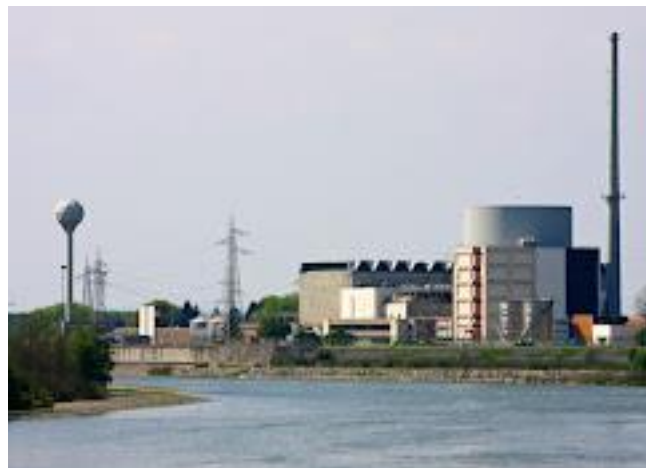
Figura 1. Centrale E. Fermi di Trino Verellese
